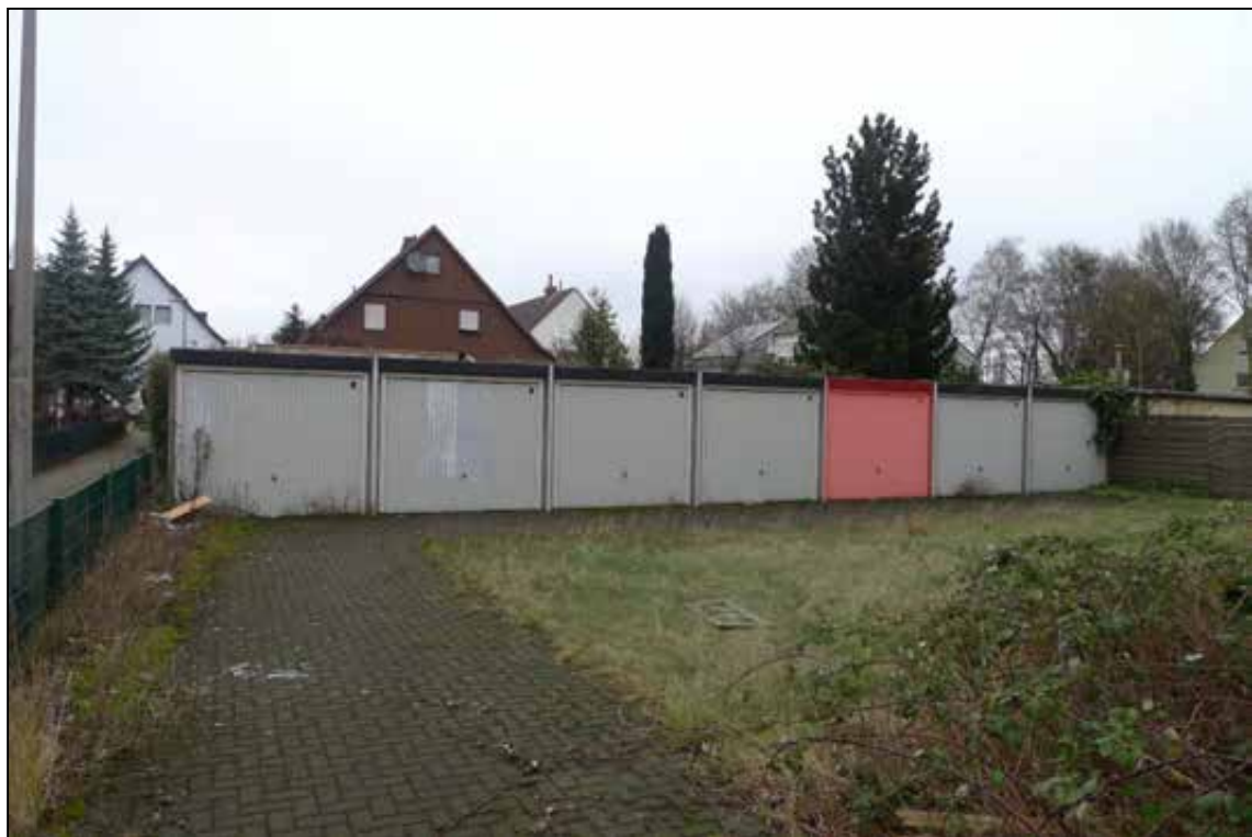
Abbildung 54 Ansicht des Garagengebäudes Das zu bewertende Sondereigentum ist rot markiert. fotografiert am 24.01.2025
