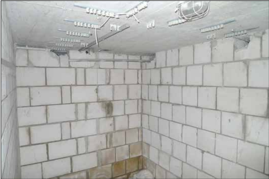
Abbildung 63 Kellerabteil des Wertermittlungsobjektes fotografiert am 24.01.2025
