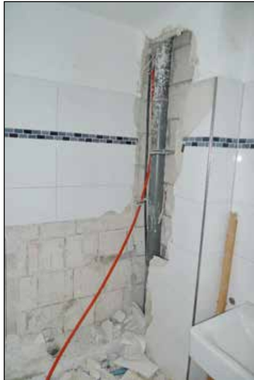
Abbildung 65 demontiertes und demoliertes Bad fotografiert am 24.01.2025
