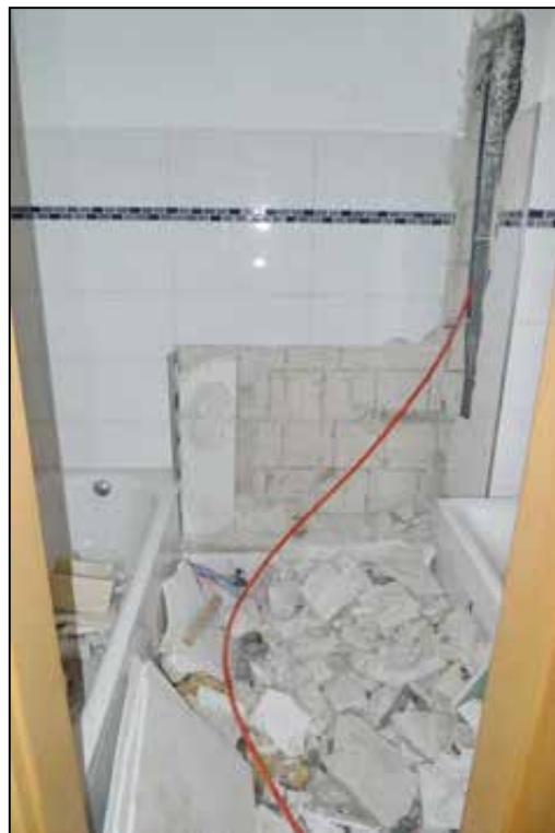
Abbildung 60 Bad des Wertermittlungsobjektes fotografiert am 24.01.2025
