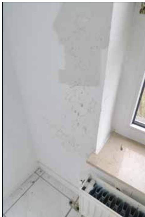
Abbildung 68 Schimmelbildung an der Außenwand im Fensterbereich fotografiert am 24.01.2025
