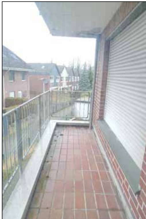
Abbildung 58 Balkon des Wertermittlungsobjektes fotografiert am 24.01.2025
