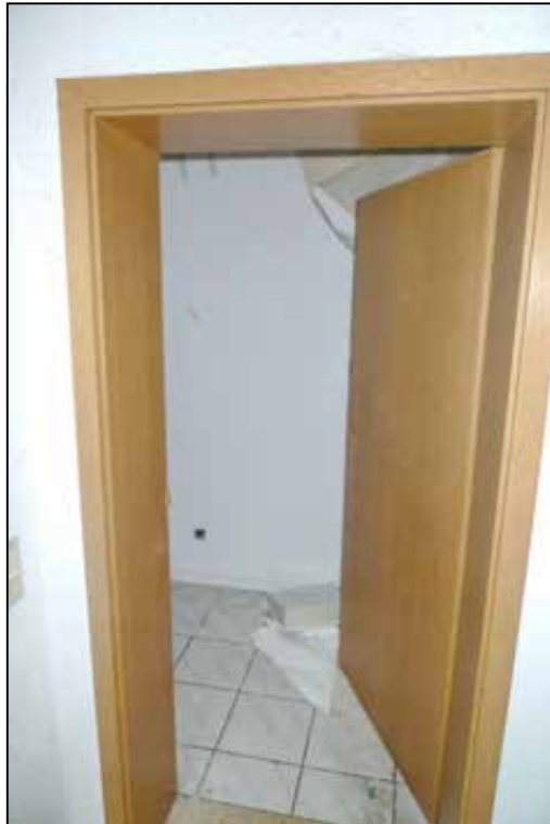
Abbildung 53 Wohnungseingangstür und Flur des Wertermittlungsobjektes fotografiert am 24.01.2025
