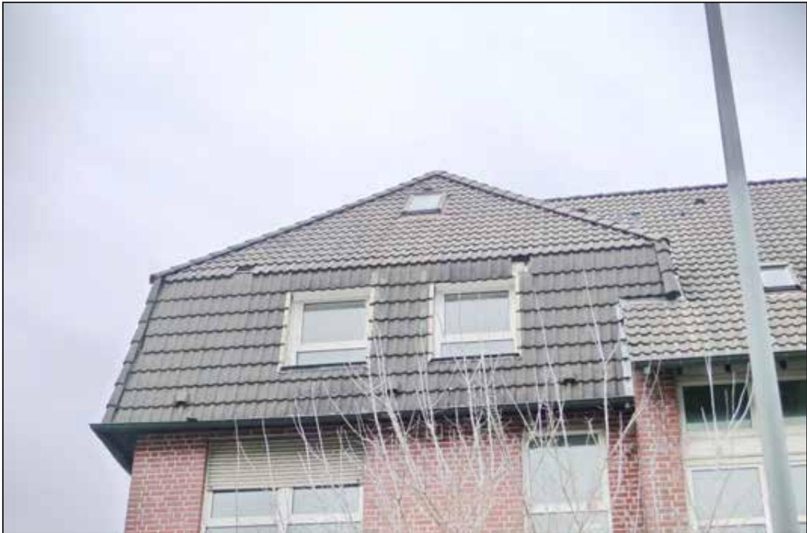
Abbildung 32 undichtiges Dach aufgrund von fehlenden Betondachsteinen
