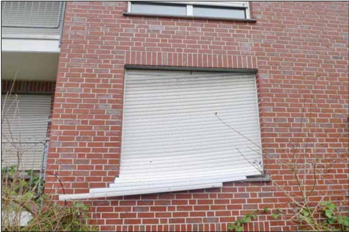
Abbildung 30 defekte Rollläden an mehreren Fenstern
