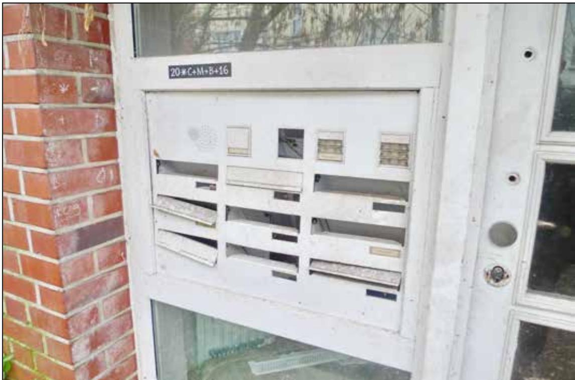
Abbildung 27 demolierte und defekte Briefkastenanlage
