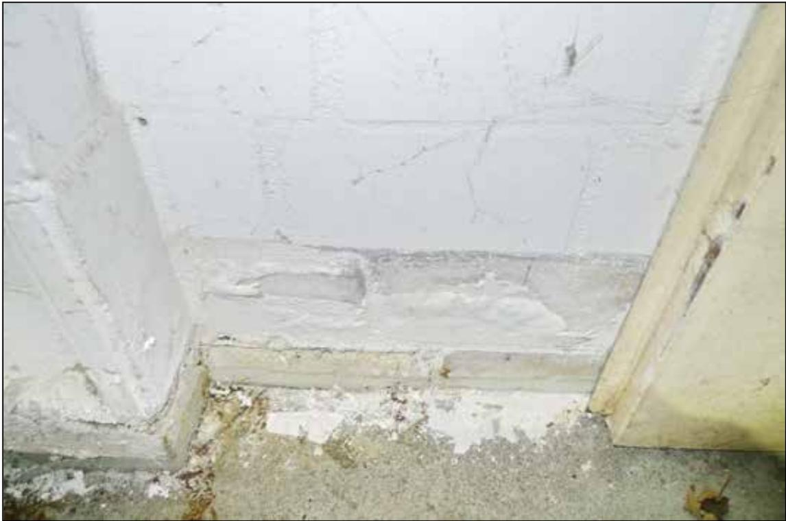
Abbildung 40 Feuchtigkeits im gesamten Kellergeschoss
