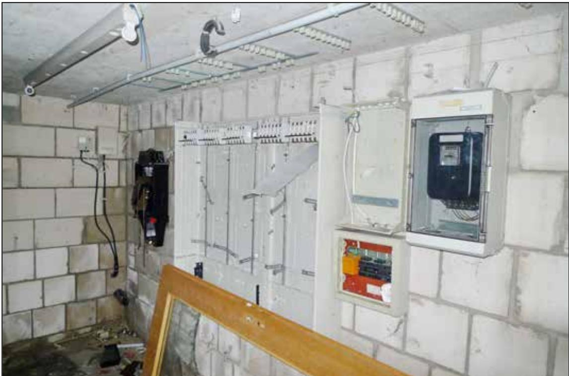
Abbildung 17 demontierte Sicherungskästen im Kellergeschoss
