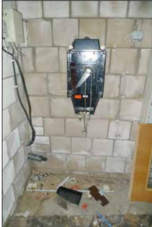
Abbildung 38 demontierte Hausanschlussleitungen
