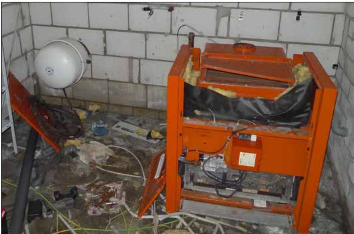
Abbildung 37 demontierte, zerstörte Heizungsanlage
