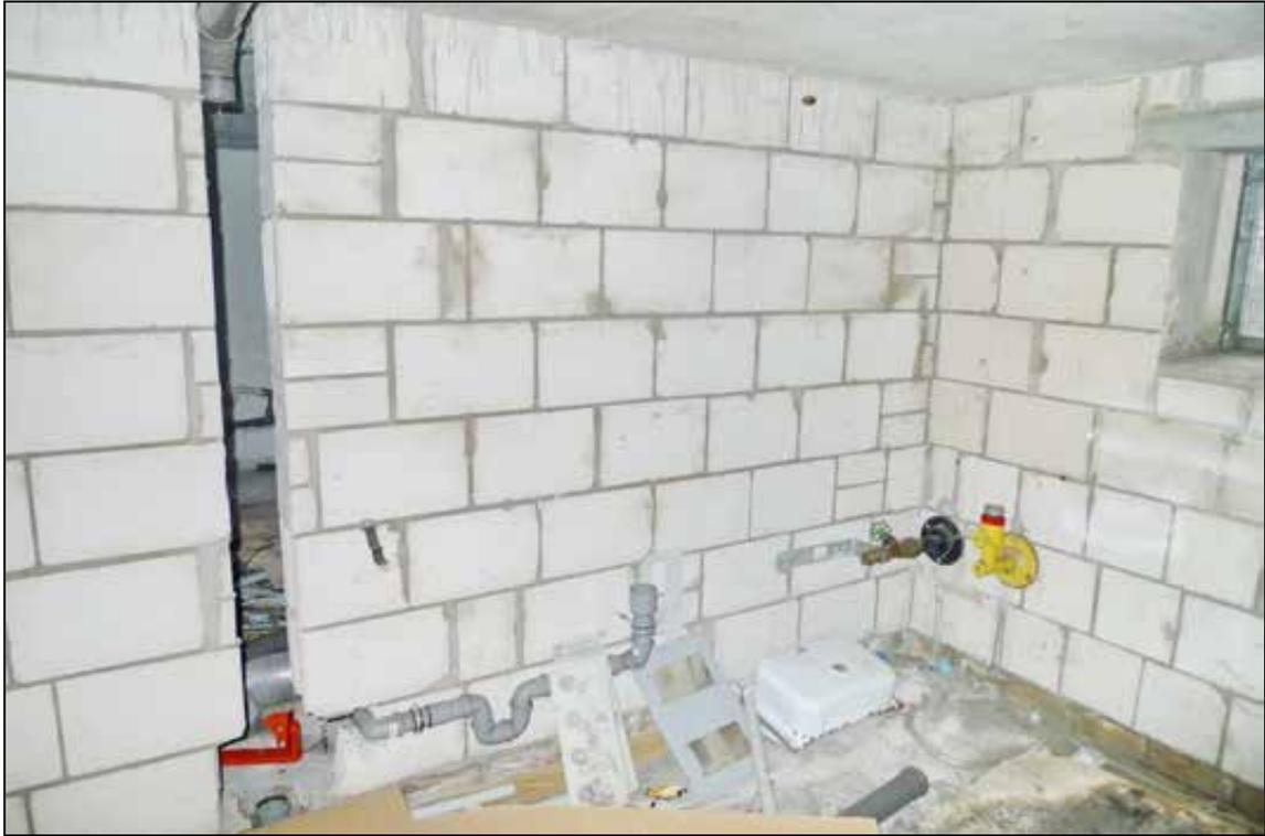
Abbildung 16 Hausanschlüsse im Kellergeschoss
