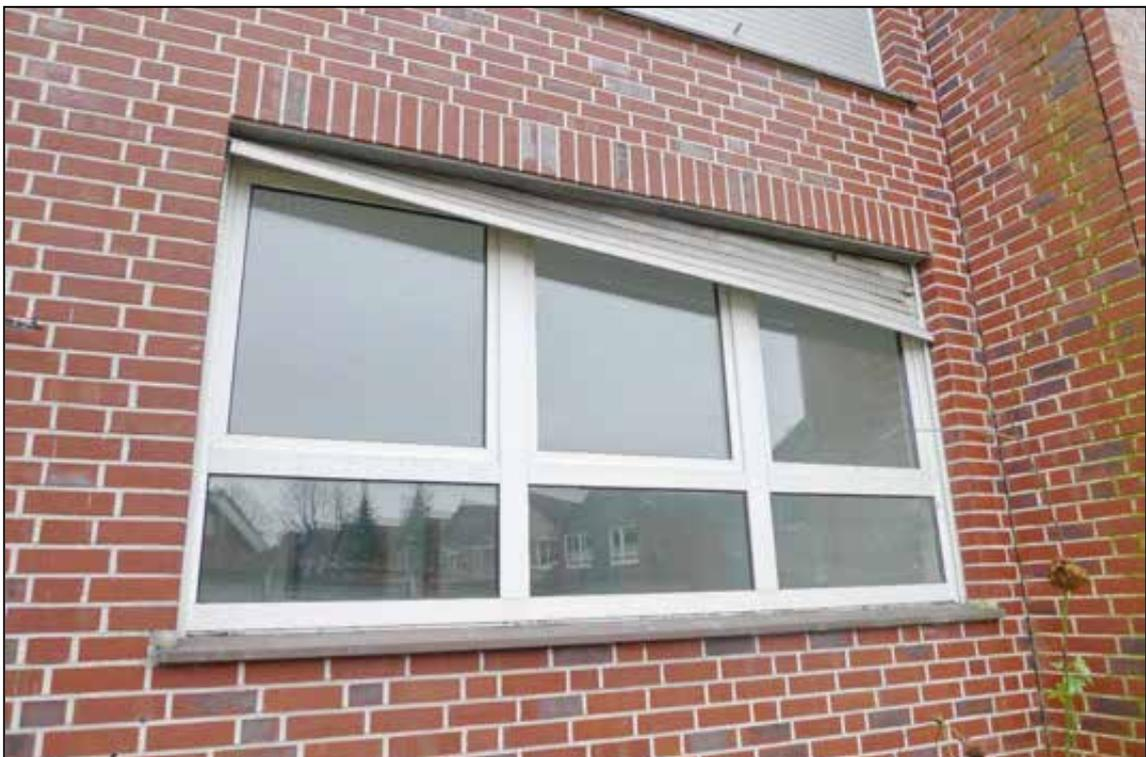
Abbildung 29 defekte Rollläden an mehreren Fenstern fotografiert am 24.01.2025
