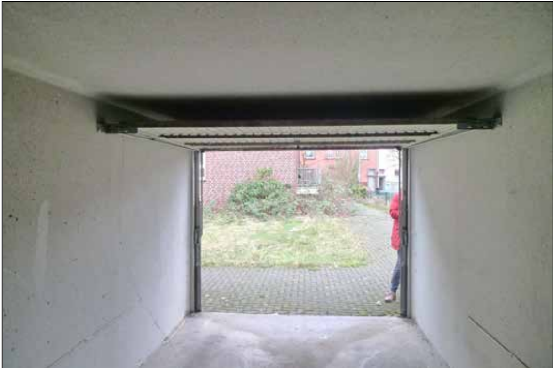
Abbildung 57 Innenansicht der Garage Nr. 11, das Wertermittlungsobjekt fotografiert am 24.01.2025
