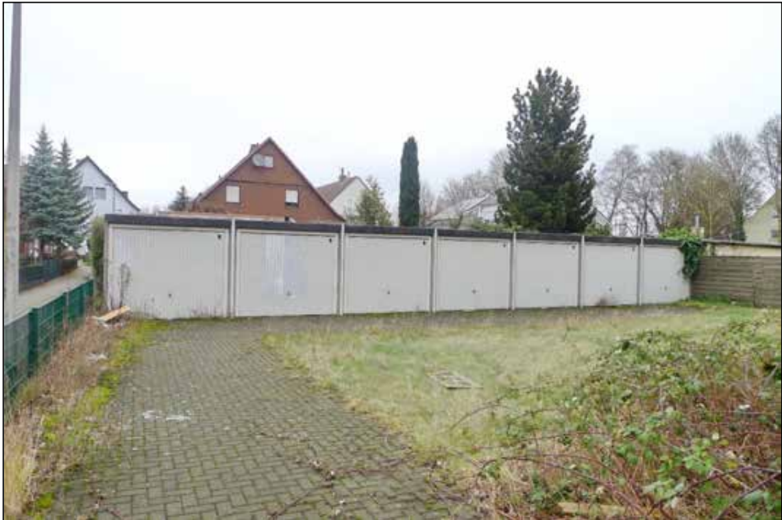
Abbildung 46 Hofansicht der baulichen Anlage Garagengebäude fotografiert am 24.01.2025
