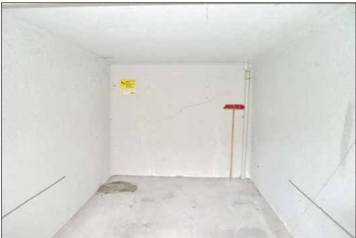
Abbildung 56 Innenansicht der Garage Nr. 11, das Wertermittlungsobjekt fotografiert am 24.01.2025
