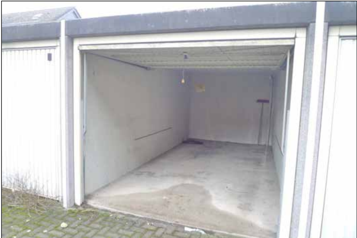
Abbildung 55 Innenansicht der Garage Nr. 11, das Wertermittlungsobjekt fotografiert am 24.01.2025
