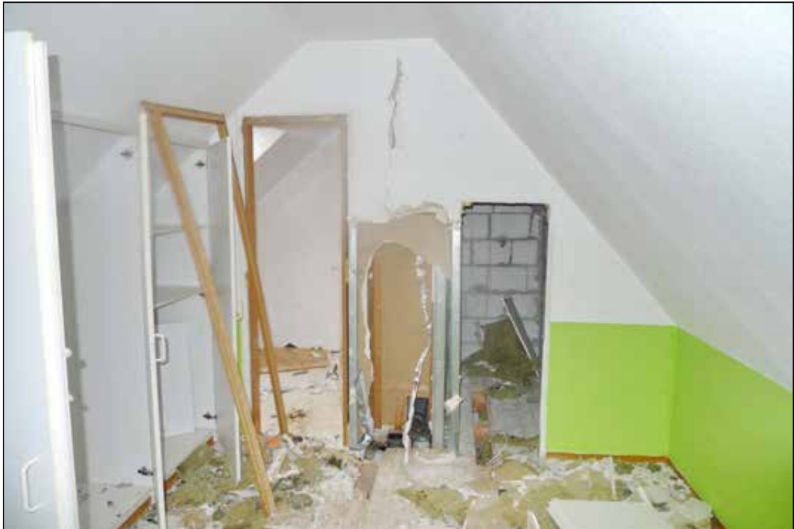
Abbildung 63 ausgebauter Raum auf dem Spitzboden fotografiert am 24.01.2025
