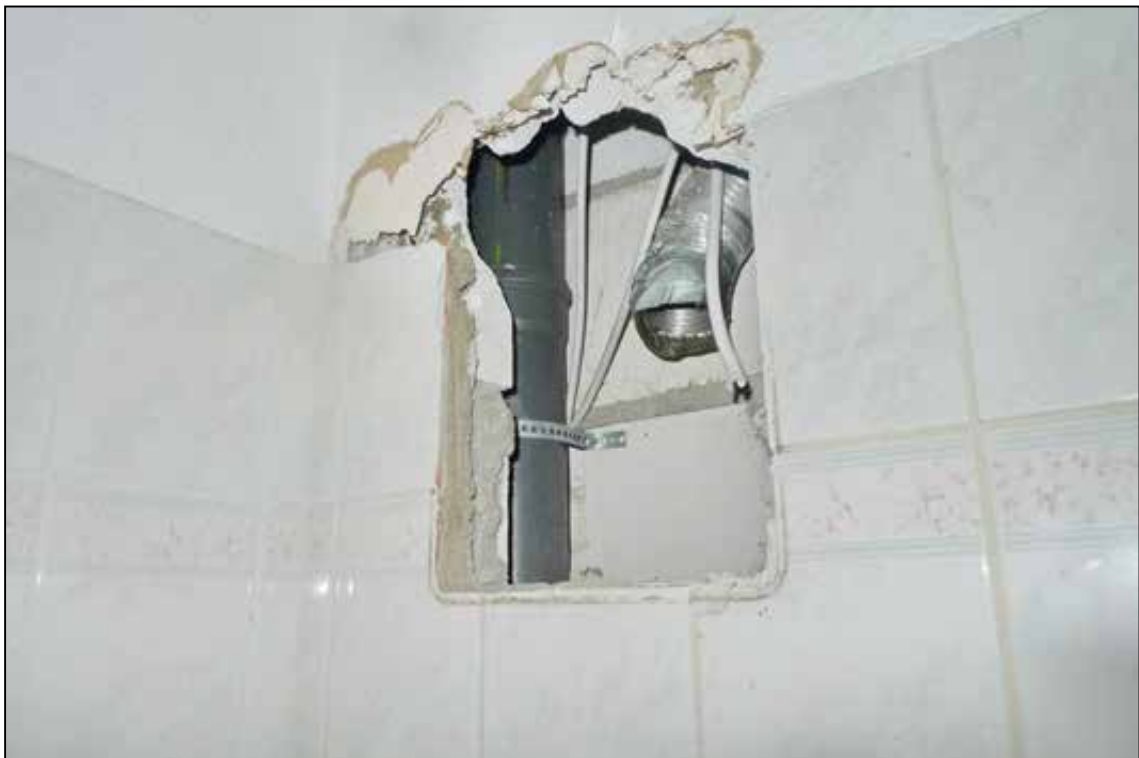
Abbildung 68 aufgerissene Wand und entfernte Leitungen im Bad fotografiert am 24.01.2025
