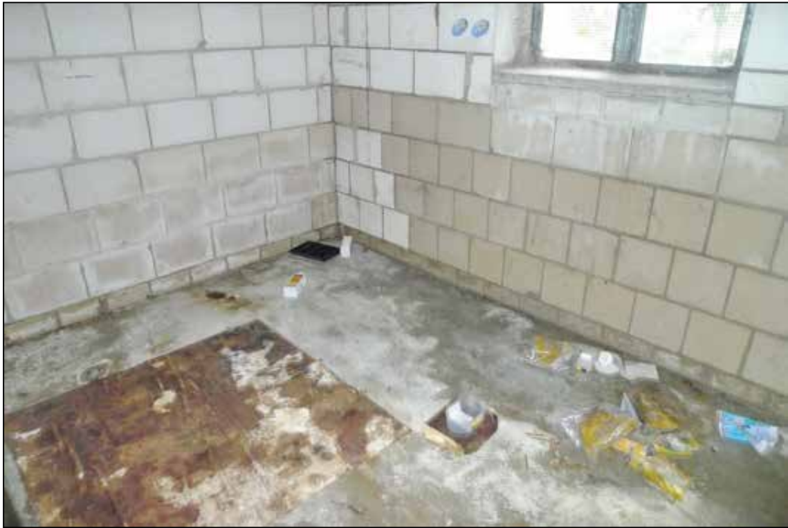
Abbildung 65 Kellerabteil des Wertermittlungsobjektes fotografiert am 24.01.2025
