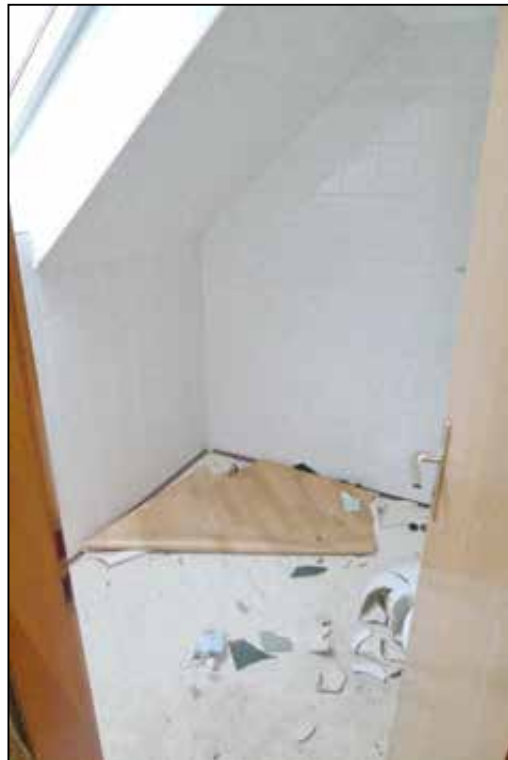
Abbildung 64 Bad auf dem Spitzboden fotografiert am 24.01.2025
