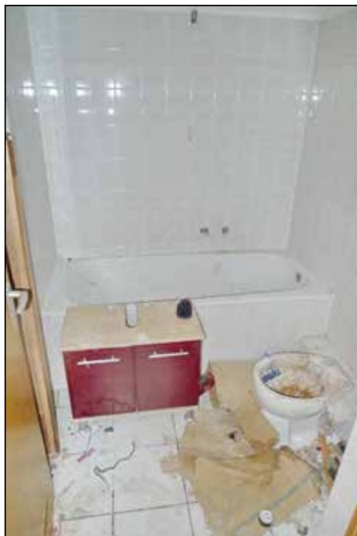
Abbildung 56 Bad des Wertermittlungsobjektes fotografiert am 24.01.2025
