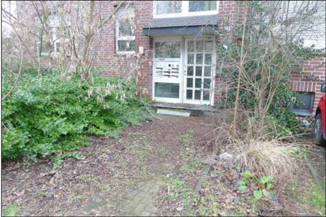
Abbildung 48 Hauszugang zur Mehrfamiliendoppelhaushälfte fotografiert am 24.01.2025
