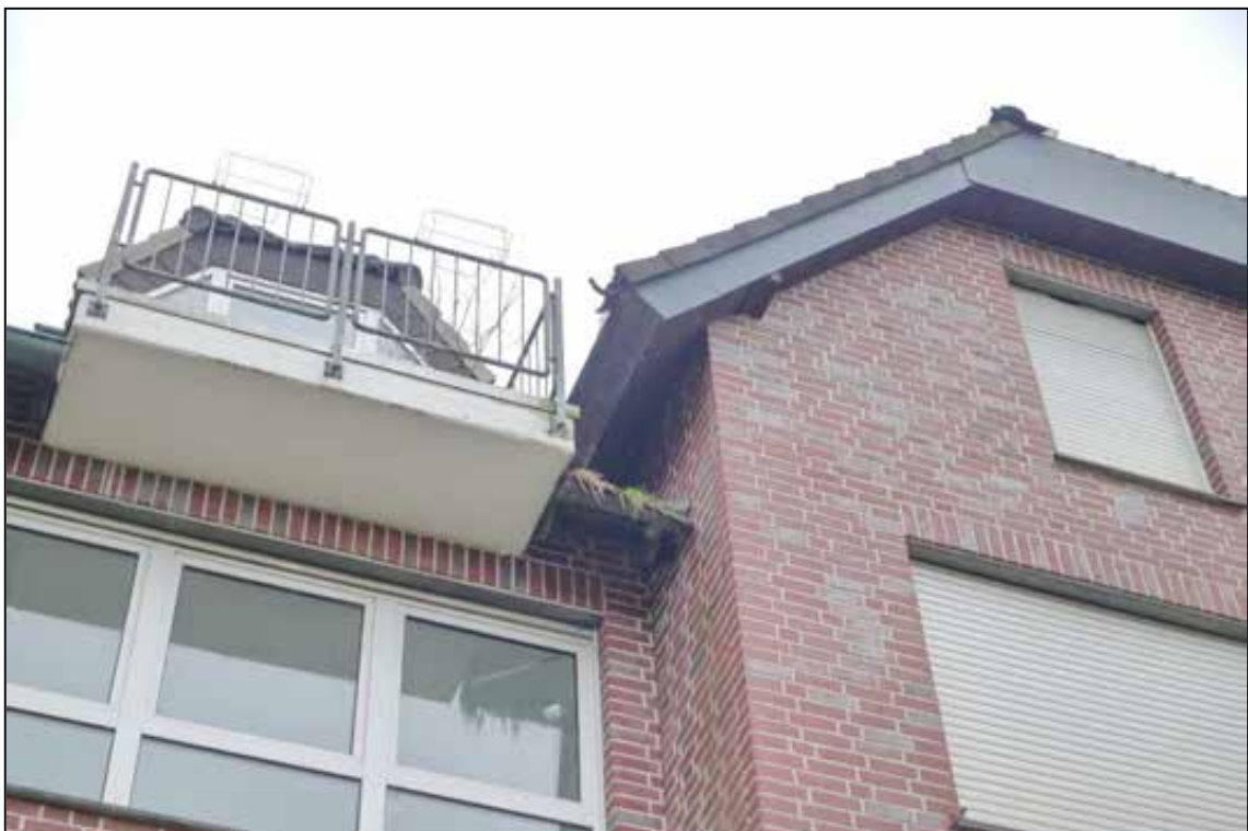
Abbildung 31 demontierte Regenfallrohre fotografiert am 24.01.2025
