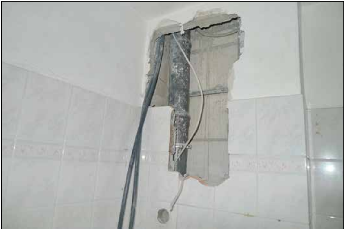
Abbildung 69 aufgebrochene Wände mit entfernten Leitungen fotografiert am 24.01.2025
