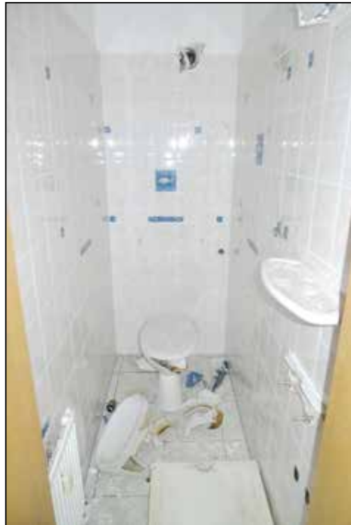
Abbildung 73 demoliertes Gäste-WC fotografiert am 24.01.2025
