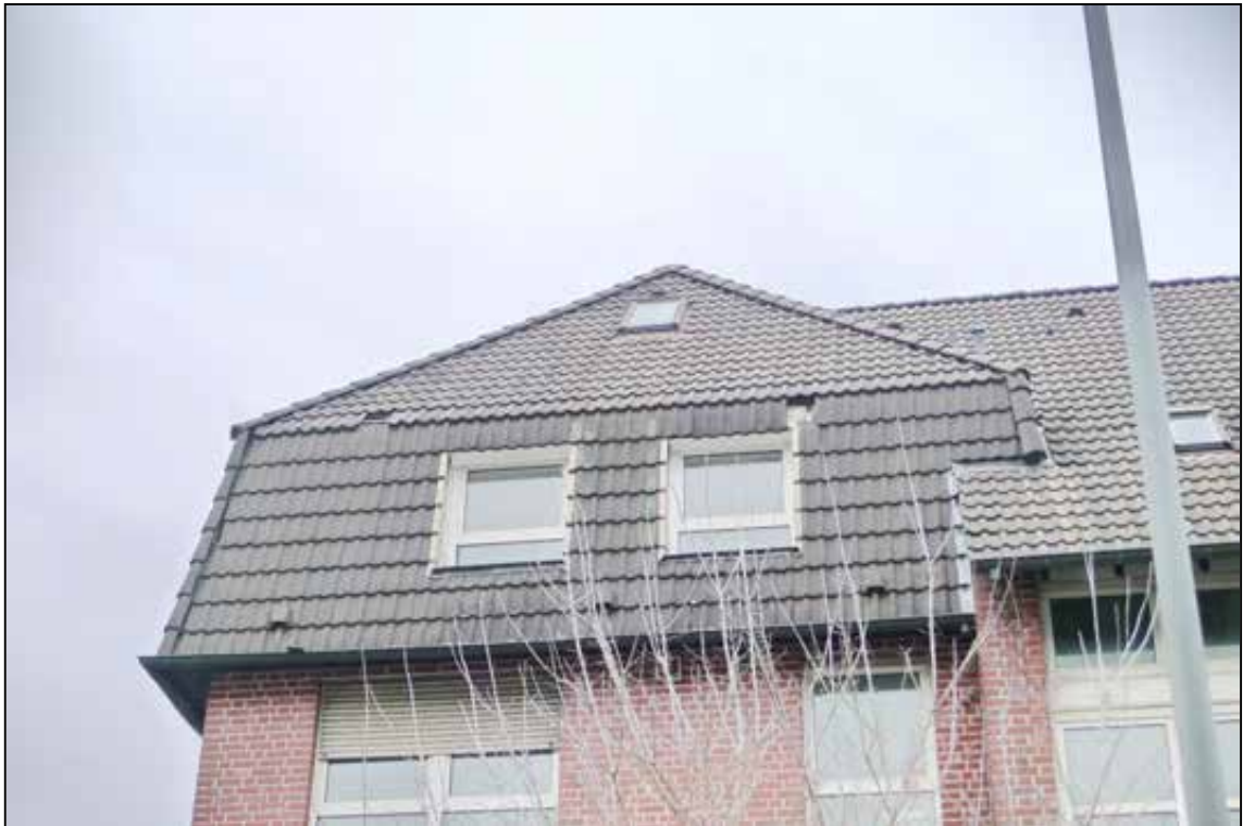
Abbildung 32 undichtiges Dach aufgrund von fehlenden Betondachsteinen fotografiert am 24.01.2025
