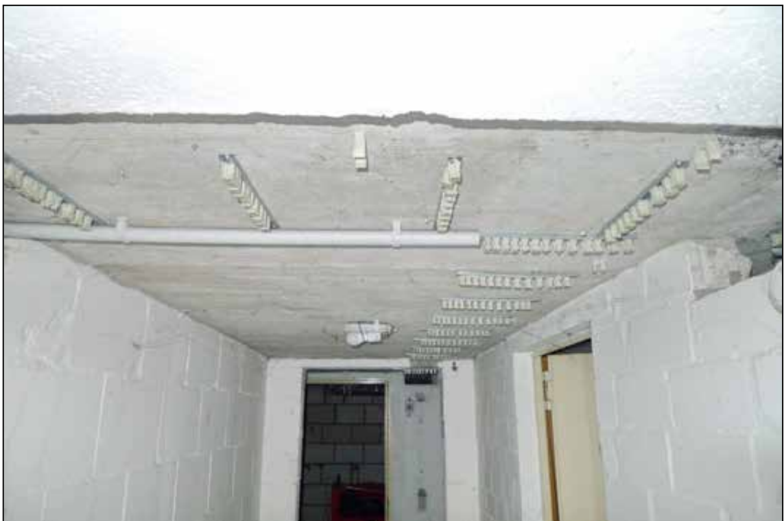
Abbildung 35 demontierte Leitungssysteme im gesamten Haus fotografiert am 24.01.2025
