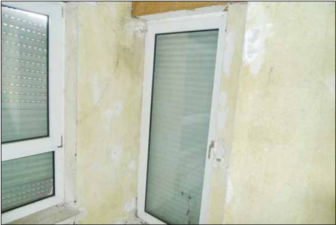
Abbildung 61 Tür im Wohnraum zum Balkon des Wertermittlungsobjektes fotografiert am 24.01.2025
