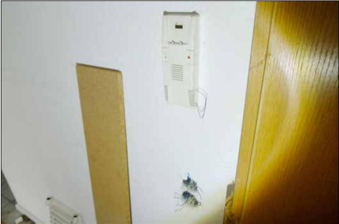
Abbildung 66 demontierte Steckdosen
