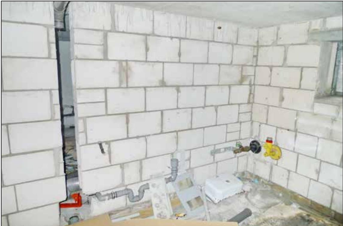
Abbildung 16 Hausanschlüsse im Kellergeschoss
