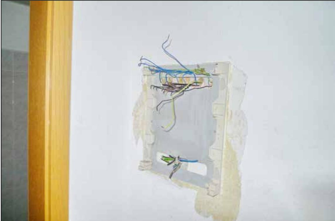
Abbildung 65 demontierter Sicherungskasten
