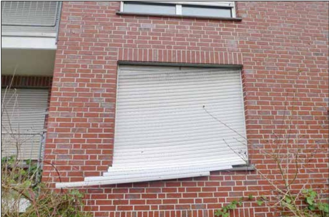
Abbildung 30 defekte Rollläden an mehreren Fenstern
