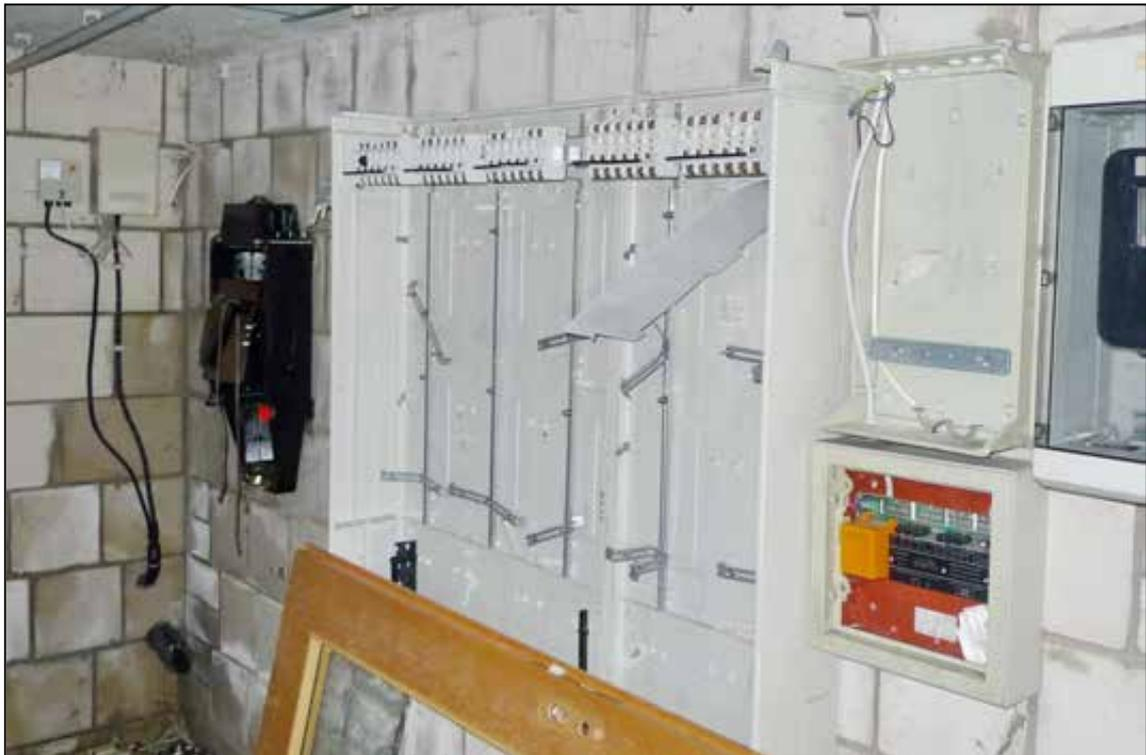
Abbildung 39 demontierte Sicherungskästen und Stromverteilungen
