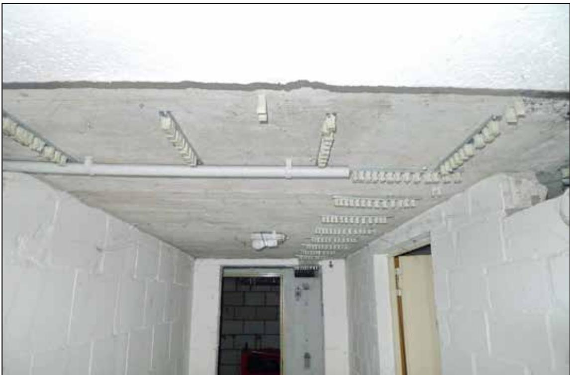
Abbildung 35 demontierte Leitungssysteme im gesamten Haus
