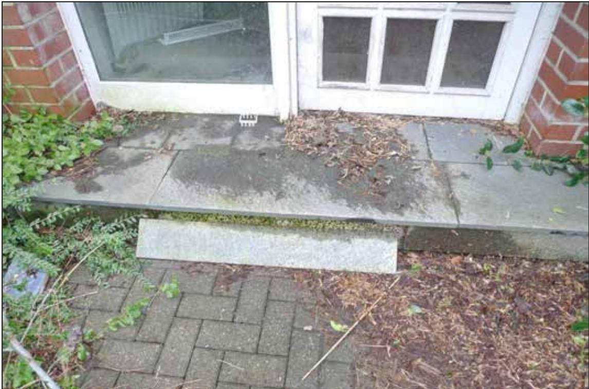
Abbildung 28 Beschädigungen des Oberbodenbelags der Differenzausgleichsstufe
