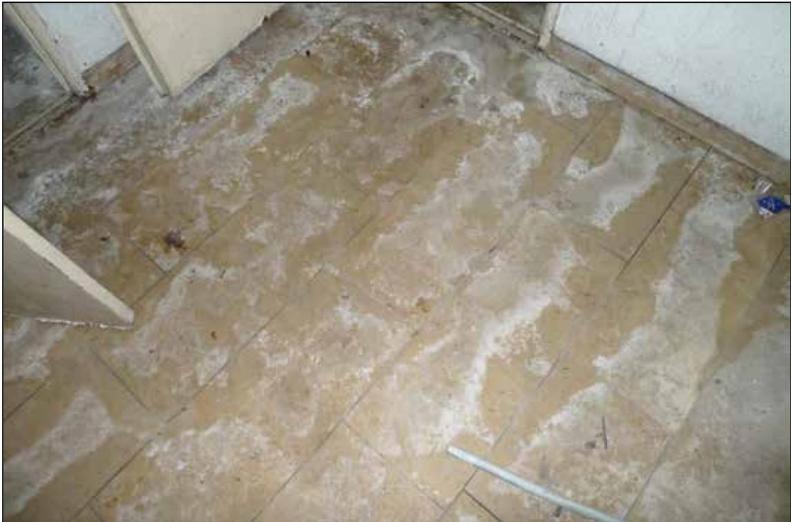
Abbildung 34 Ausblühungen auf dem Fußbodenoberbelag im Kellergeschoss
