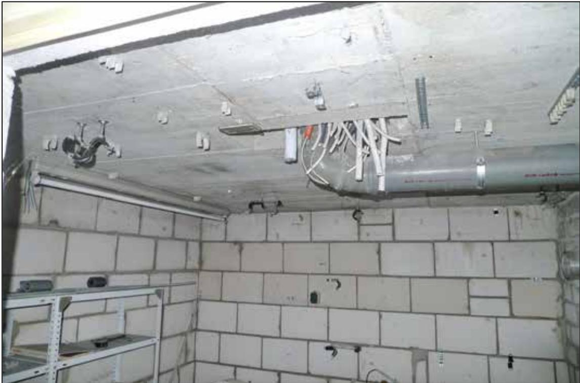
Abbildung 36 demontierte Leitungssysteme im gesamten Haus
