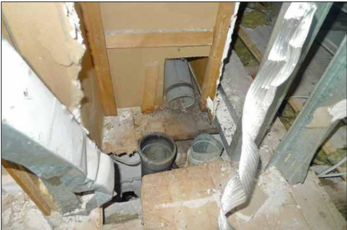
Abbildung 41 demontierte Leitungen auf dem Spitzboden
