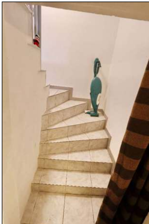
Abbildung 14 Treppe zum Erdgeschoss Foto Nr. 9, fotografiert am 21.01.2026
