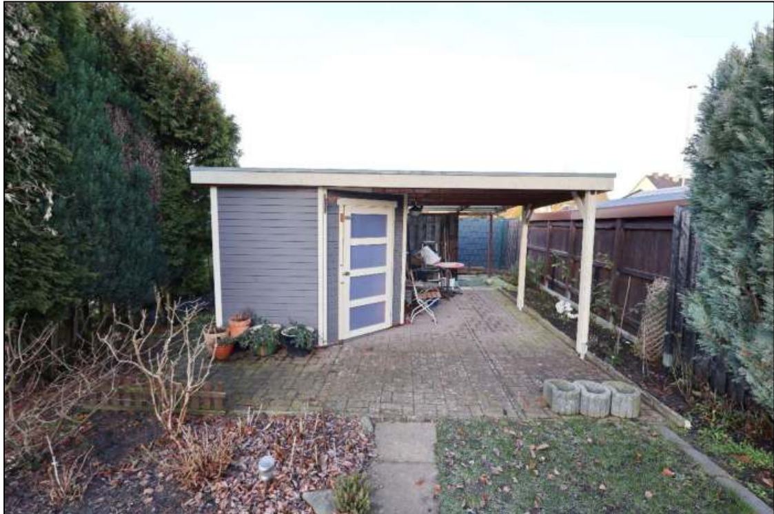
Abbildung 44 Gartengeräteschuppen in Holzbauweise Foto Nr. 35, fotografiert am 21.01.2026
