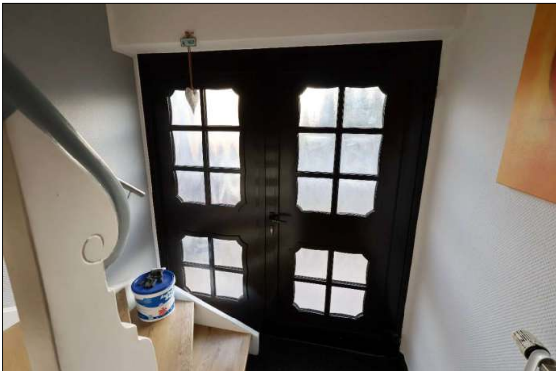
Abbildung 20 Hauseingangstür im Erdgeschoss des Altbaus Foto Nr. 15, fotografiert am 21.01.2026
