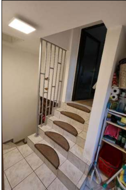
Abbildung 15 Flur im Anbau mit Zugang zum Keller- und Erdgeschoss des Altbaus Foto Nr. 10, fotografiert am 21.01.2026
