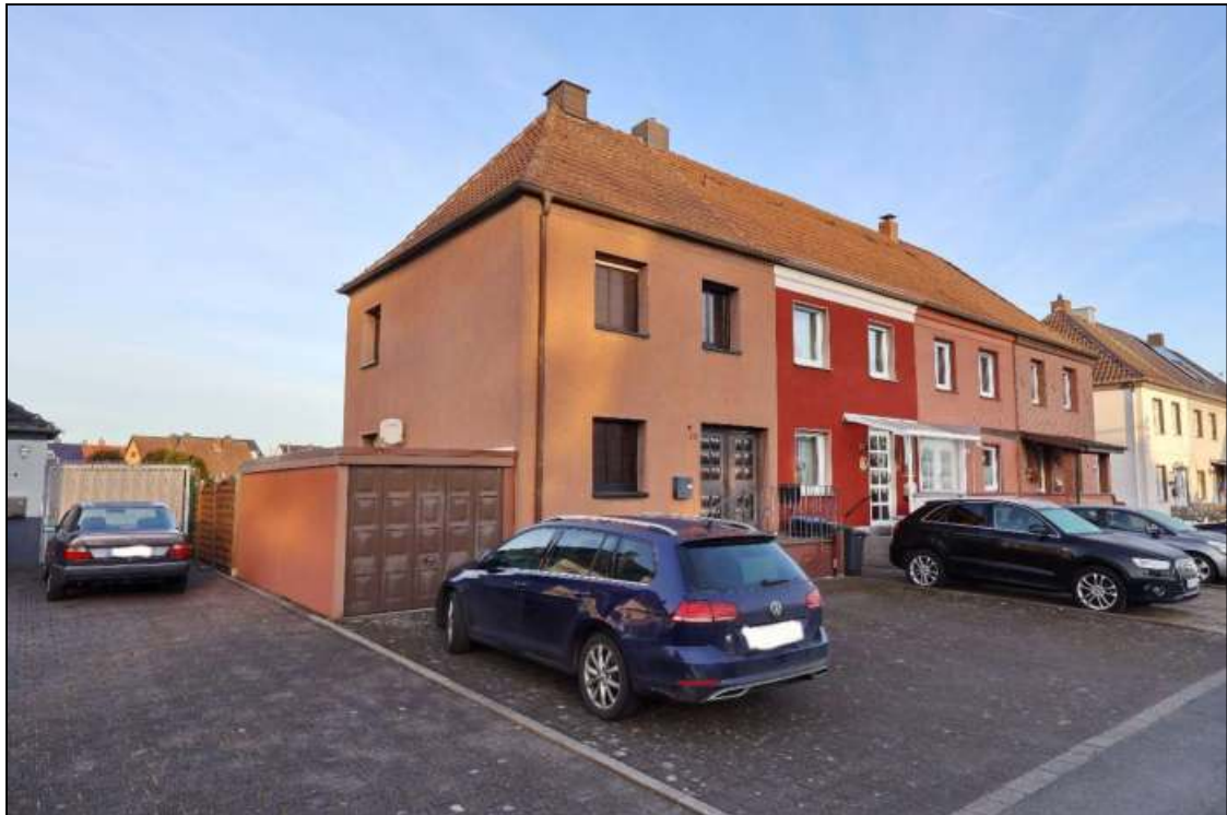
Abbildung 40 Auffahrt vor den baulichen Anlagen mit Haus- und Garagenzugang Foto Nr. 31, fotografiert am 21.01.2026
