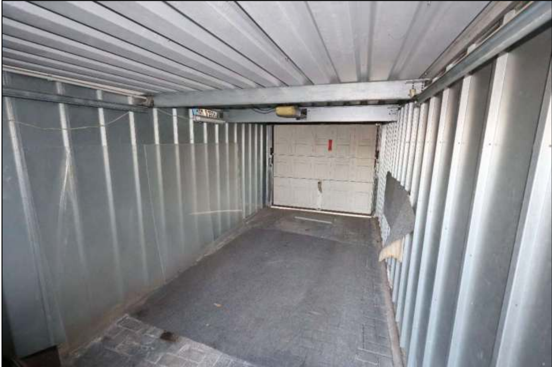
Abbildung 39 Innenansicht der Garage Foto Nr. 30, fotografiert am 21.01.2026
