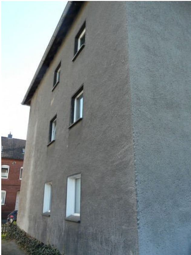
Ansicht von Nordosten (HsNr. 33)
