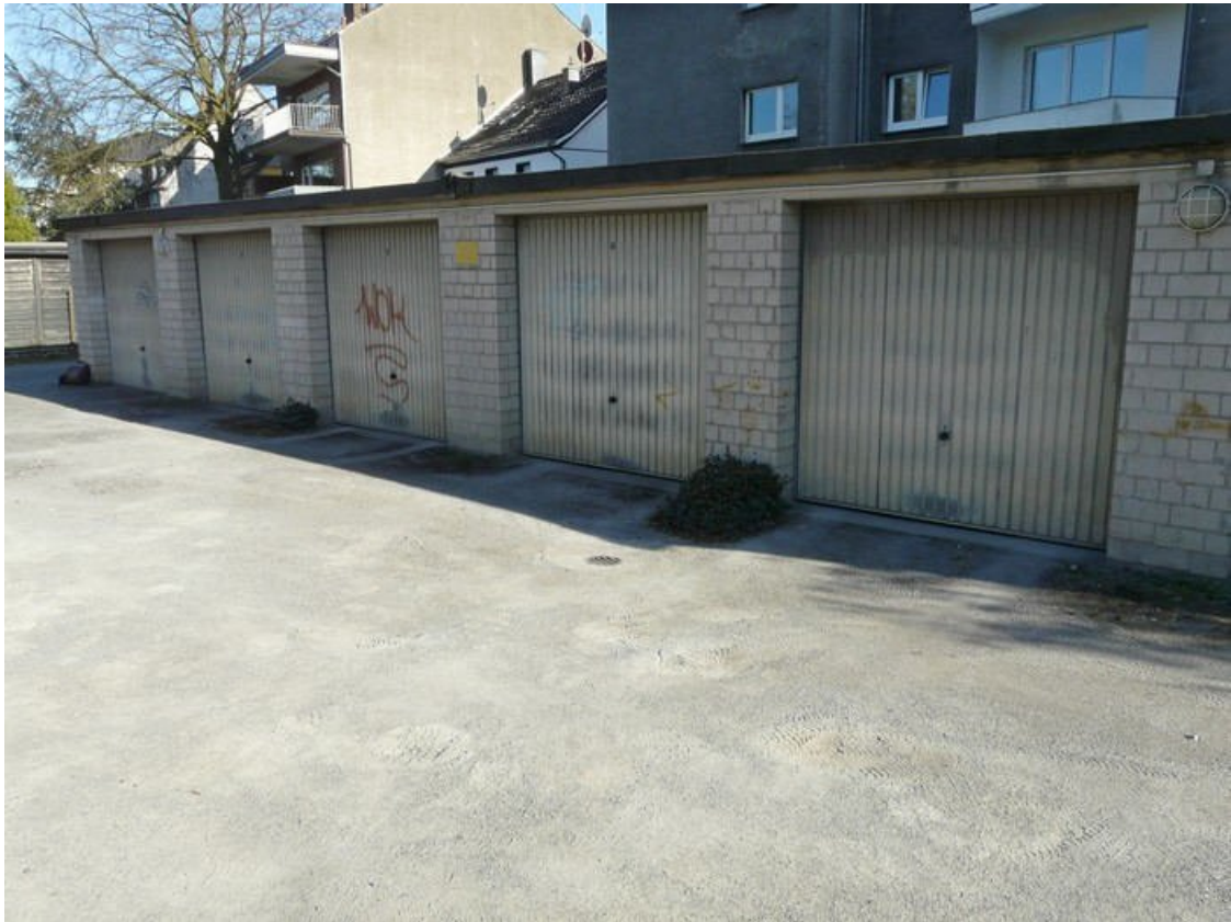
Teilansicht von Nordwesten (Reihengarage v. 1976)
