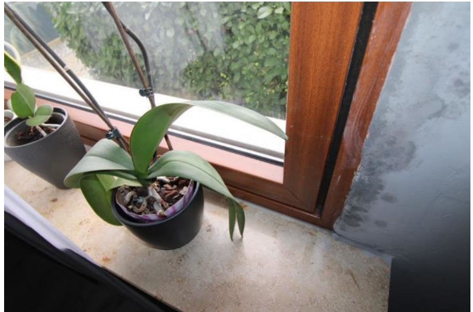
Fenster Wohnzimmer Zustand.
