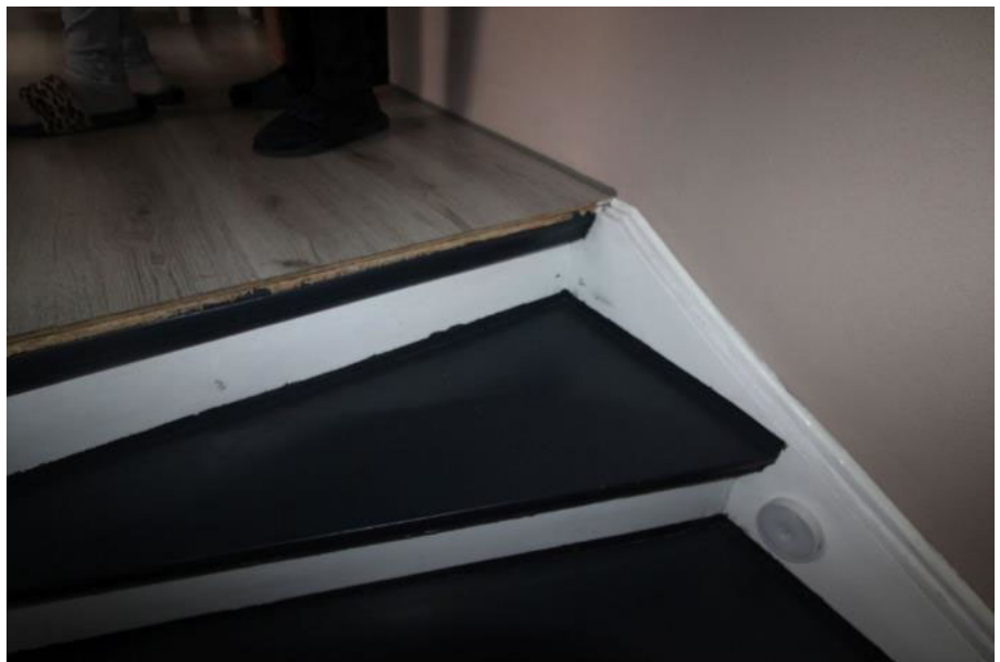
Treppe zum Oberge- schoss.
