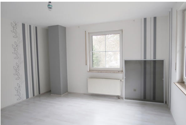
Obergeschoss – „Kinder 1“ mit nachträglich eingebautem Schornstein im Hintergrund links.
