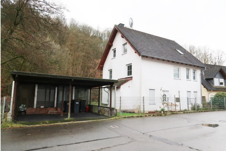
Ansicht von Nordosten mit Doppelcarport
