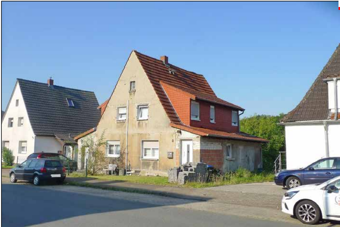
Abbildung 10 Straßenansicht der Einfamilien-Doppelhaushälfte (rechte Haushälfte) auf dem zu bewertenden Grundstück fotografiert am 13.08.2024
