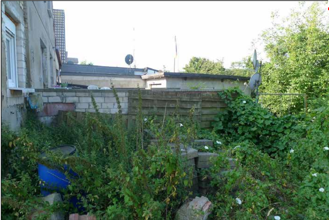
Abbildung 21 nicht abgeschlossene Putzarbeiten an der Terrasse der Einfamilien-Doppelhaushälfte auf dem zu bewertenden Grundstück fotografiert am 13.08.2024
