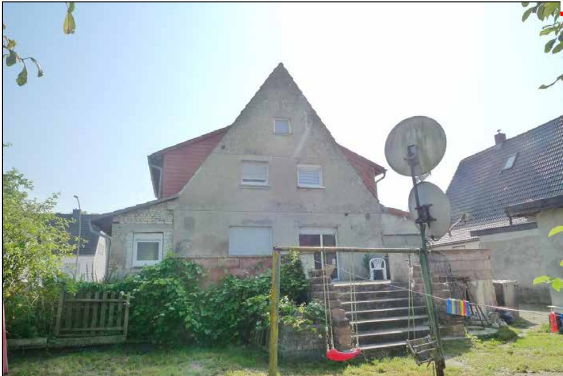
Abbildung 12 Rückansicht der Einfamilien-Doppelhaushälfte (linke Haushälfte) auf dem zu bewertenden Grundstück fotografiert am 13.08.2024
