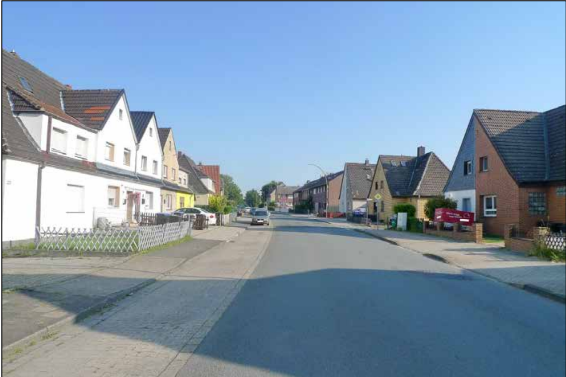
Abbildung 2 Umgebungsbebauung des zu bewertenden Grundstücks fotografiert am 13.08.2024
