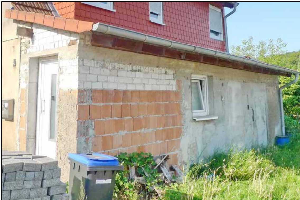
Abbildung 16 nicht abgeschlossene Putzarbeiten an der Erdgeschossweiterung der Einfamilien-Doppelhaushälfte auf dem zu bewertenden Grundstück fotografiert am 13.08.2024
