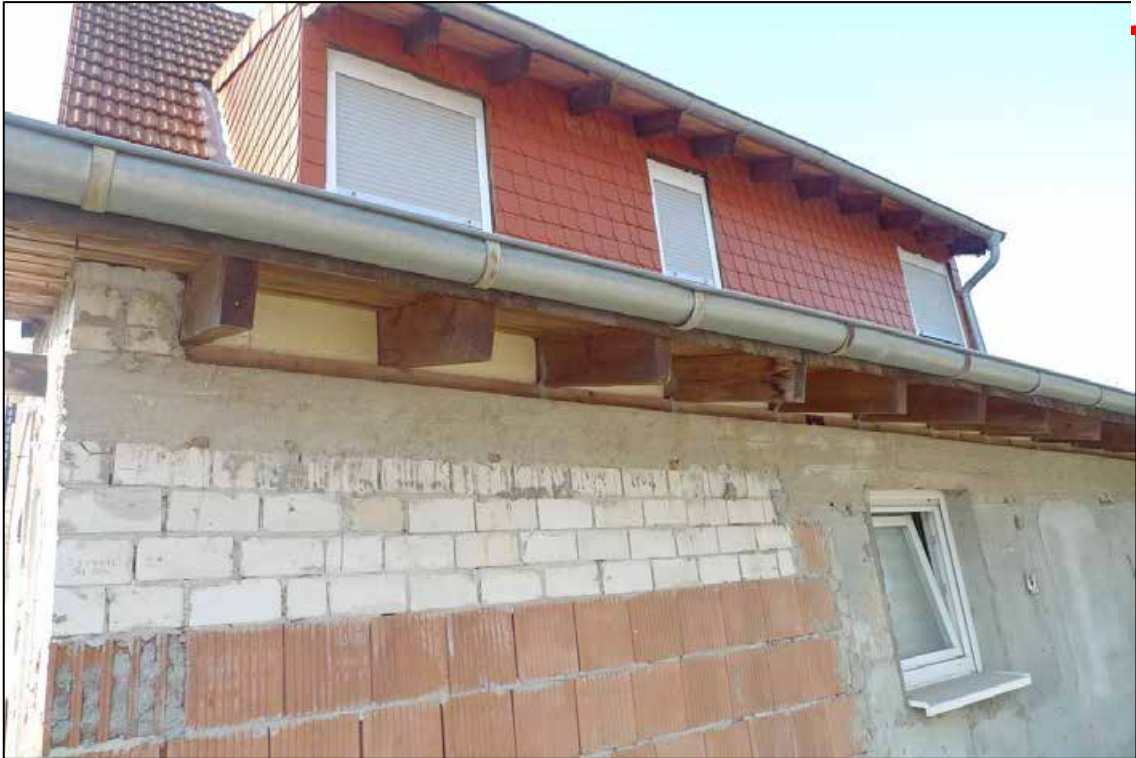
Abbildung 17 nicht abgeschlossene Dacharbeiten an der Erdgeschossweiterung der Einfamilien-Doppelhaushälfte auf dem zu bewertenden Grundstück fotografiert am 13.08.2024
