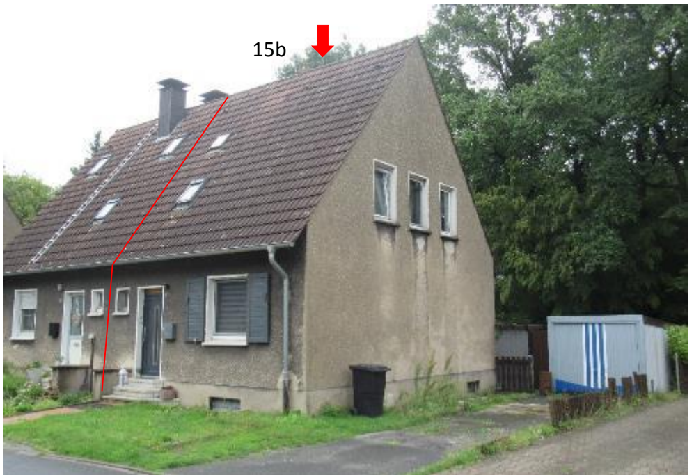
Kruppstraße 15a / 15b
