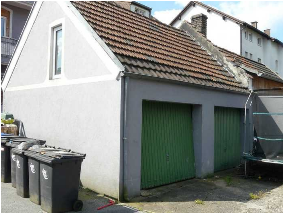
Ansicht von Nordosten (Doppelgarage)
