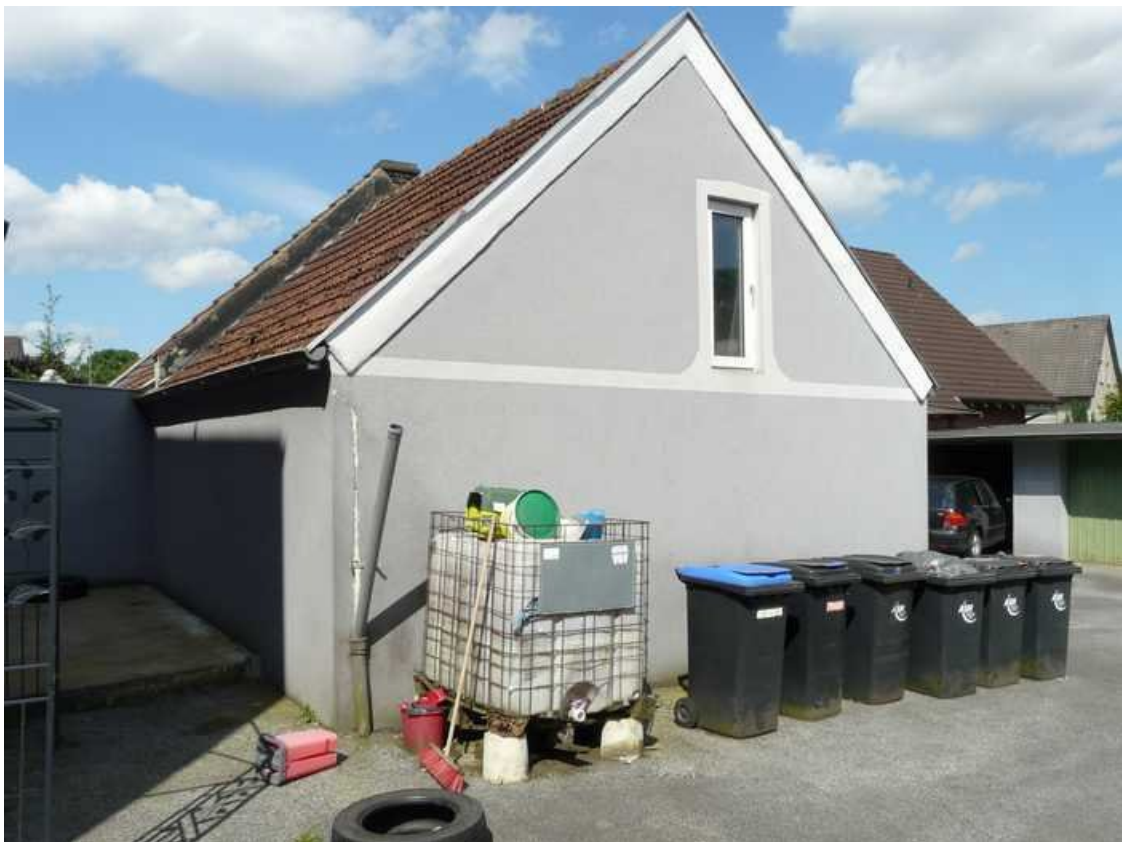
Ansicht von Osten (Doppelgarage)
