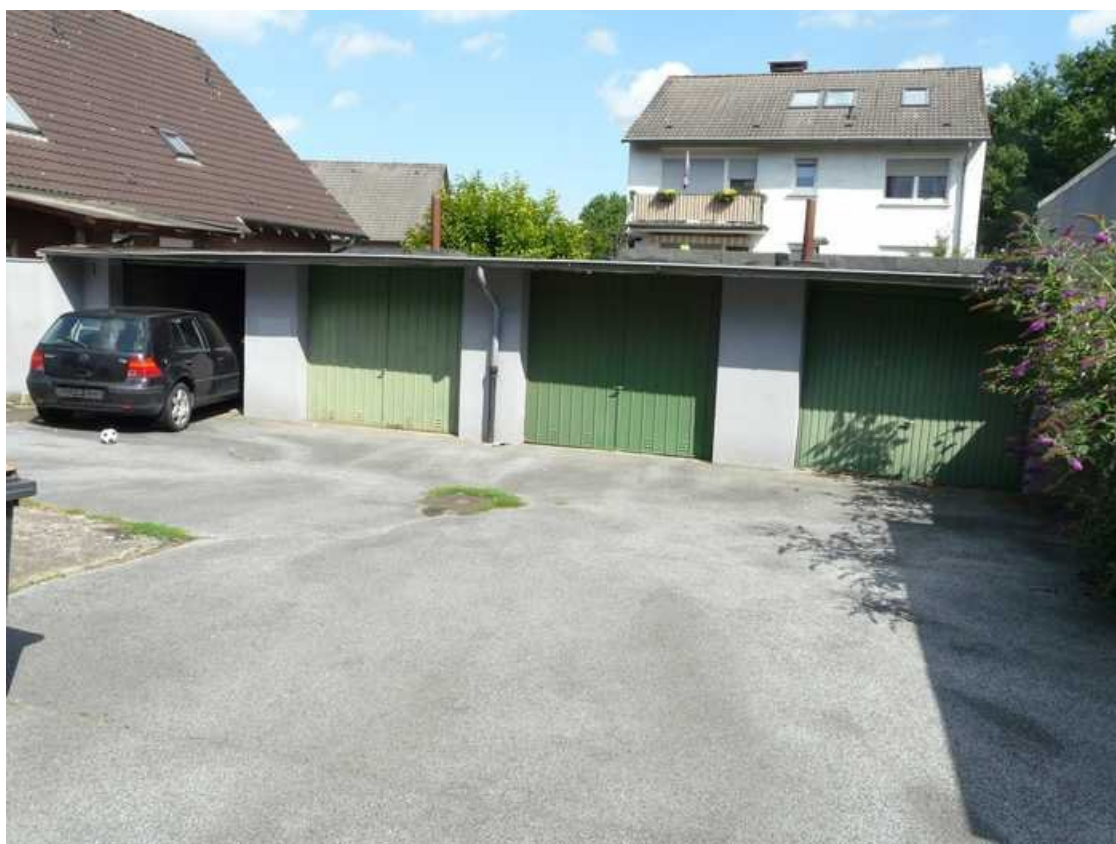
Ansicht von Süden (Reihengarage)
