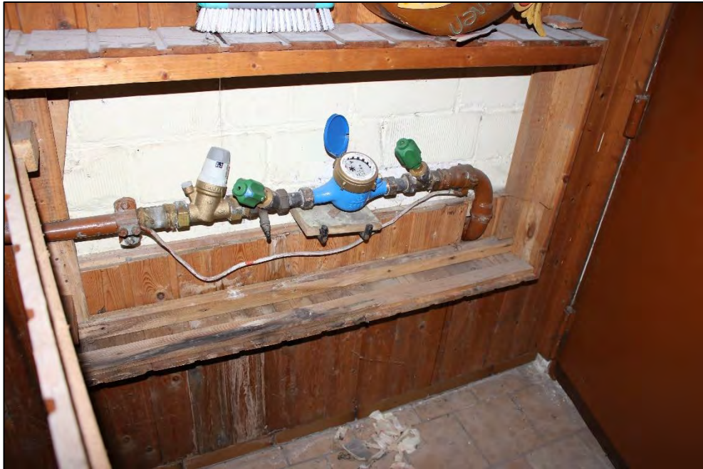
Foto Nr. 21: Kellergeschoss, Wasserhausanschluss
