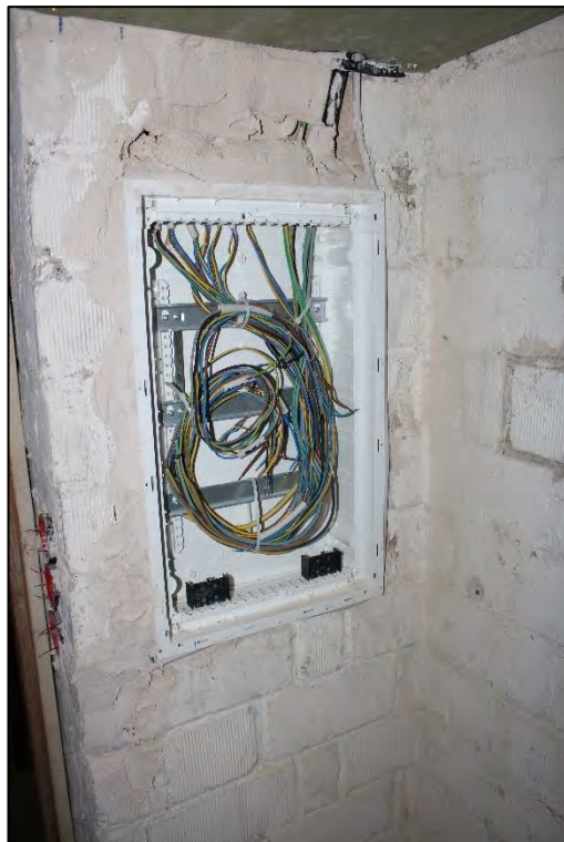
Foto Nr. 30: Kellergeschoss, Kellerraum / neue Elektrounterverteilung
