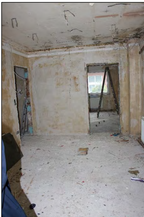
Foto Nr. 46: Erdgeschoss, ETW Nr. 1, Esszimmer / Feuchteschäden
