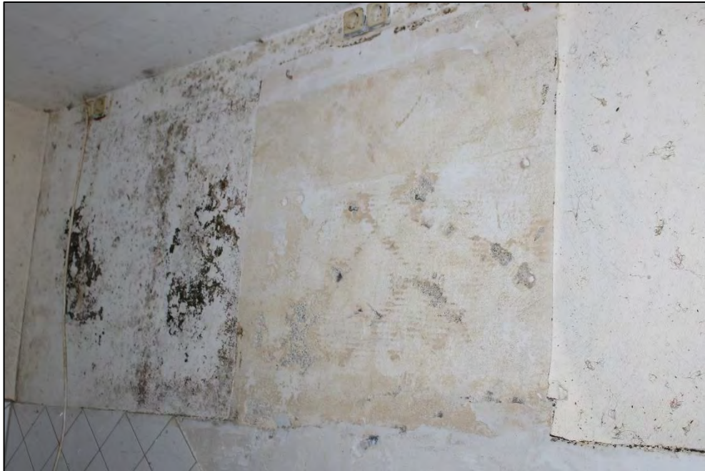
Foto Nr. 41: Erdgeschoss, ETW Nr. 1, Küche / Feuchteschäden
