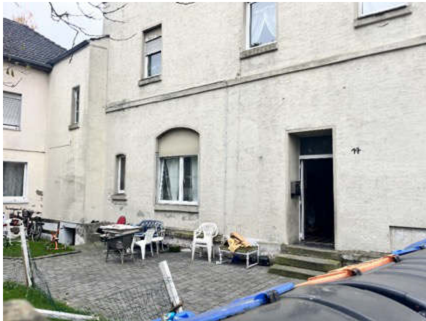
Bild 9: Eingang zu den Wohnungen im Haus Nr. 14
