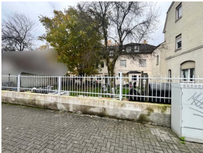
Bild 4: Ansicht von der Straße aus, Hofgebäude
