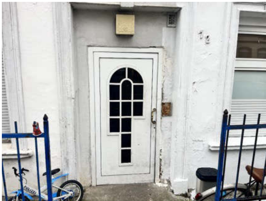
Bild 16: Eingang Haus Nr. 12
