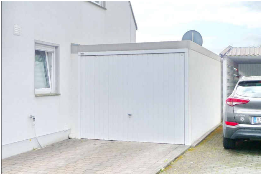
Abbildung 18 Straßenansicht der baulichen Anlage Garage fotografiert am 26.05.2025
