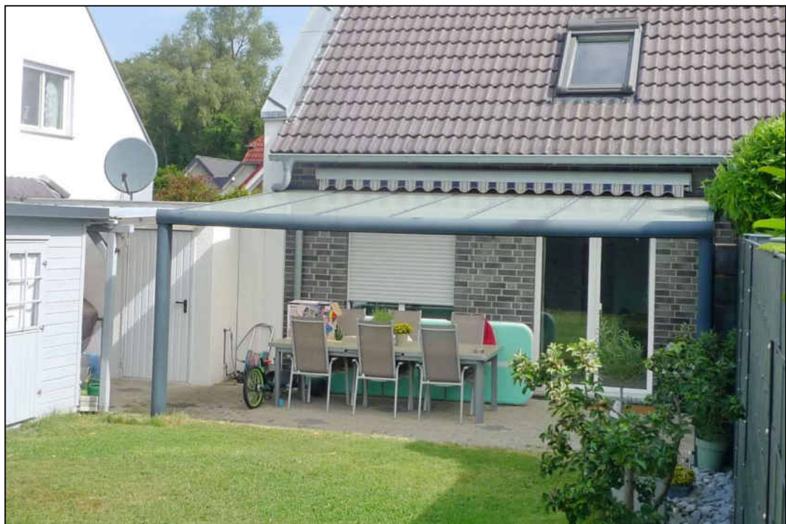
Abbildung 21 überdachte Terrasse im Garten des zu bewertenden Grundstücks fotografiert am 26.05.2025
