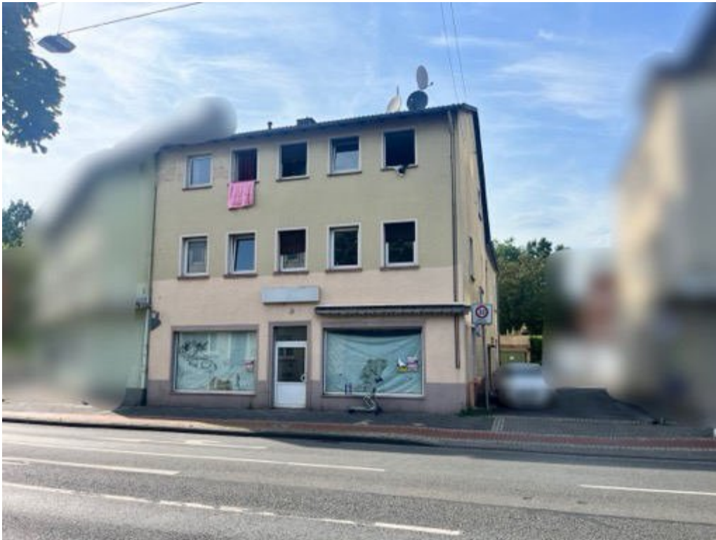
Objektansicht von vorne (aus Richtung Wilhelmstraße) Zugang Ladenlokal
