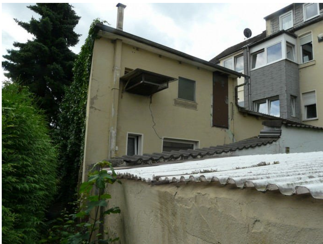
Teilansicht von Norden
