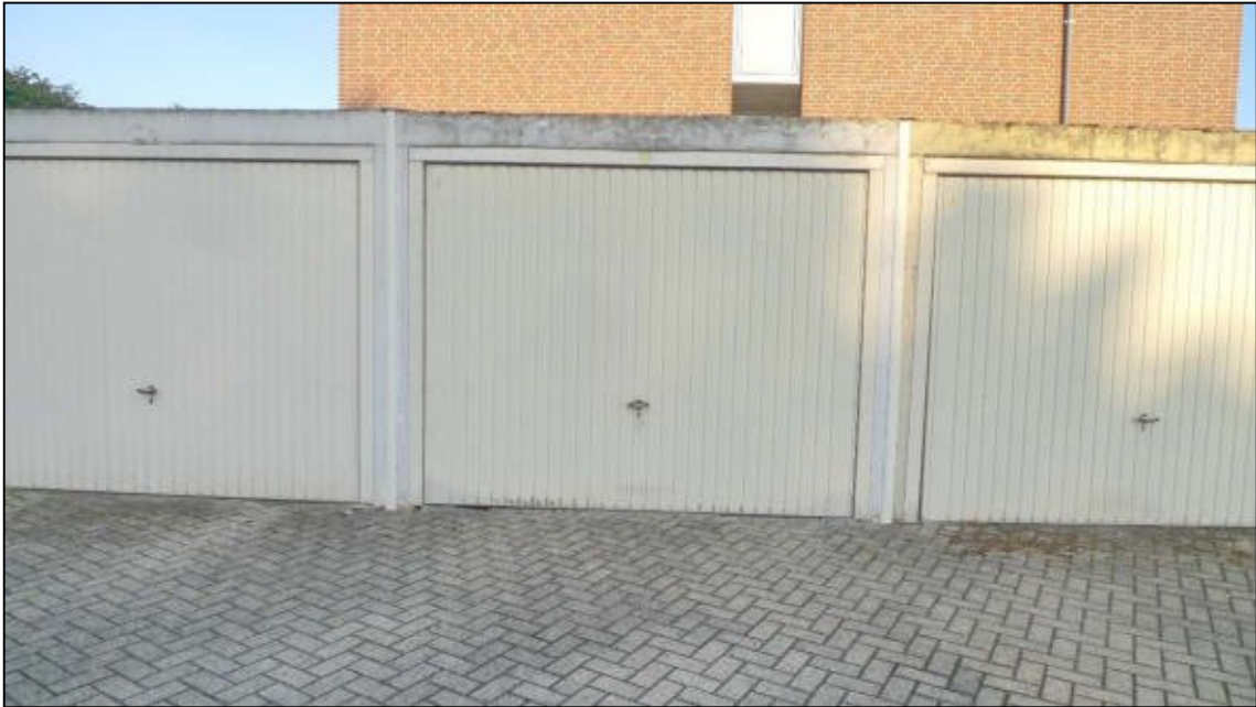
Abbildung 20 Ansicht der baulichen Anlage Garage Foto Nr. 5, fotografiert am 06.08.2025
