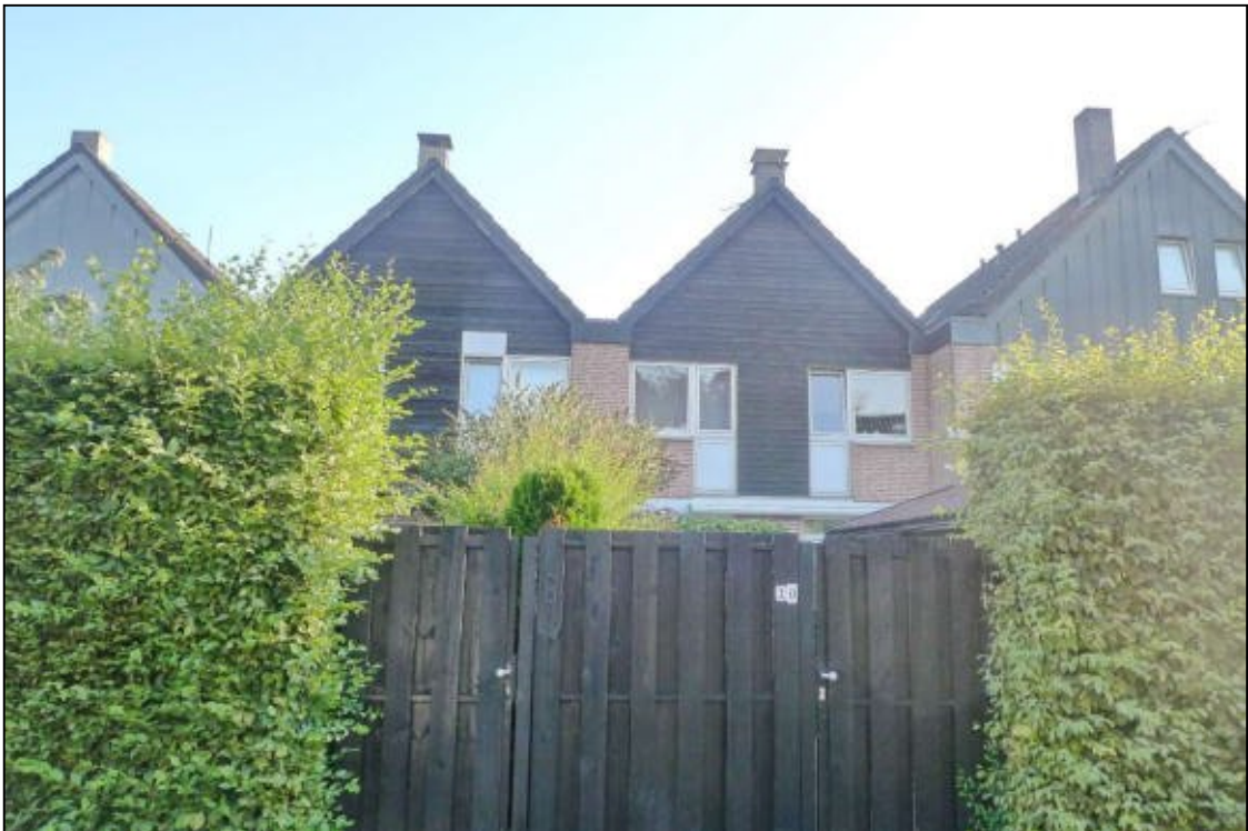
Abbildung 15 Rückansicht der baulichen Anlage Einfamilienreihenmittelhaus Foto Nr. 4, fotografiert am 06.08.2025
