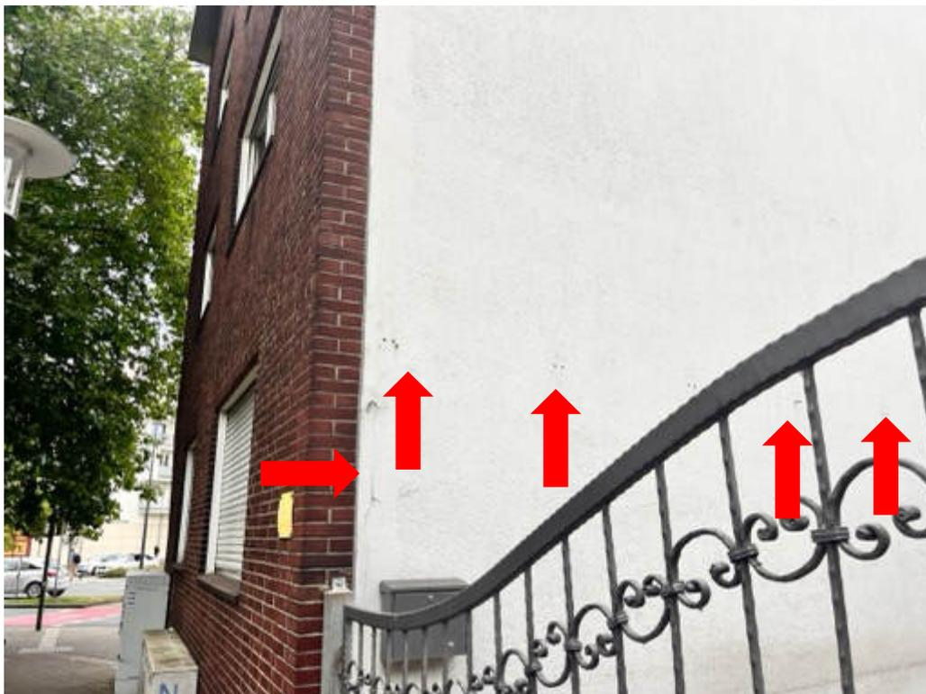
Farb- und Putzabplatzungen sowie Bohrlöcher in der Außenwand (Hofseite)
