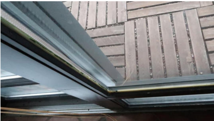
Dichtungen teilweise erneue- rungsbedürftig
