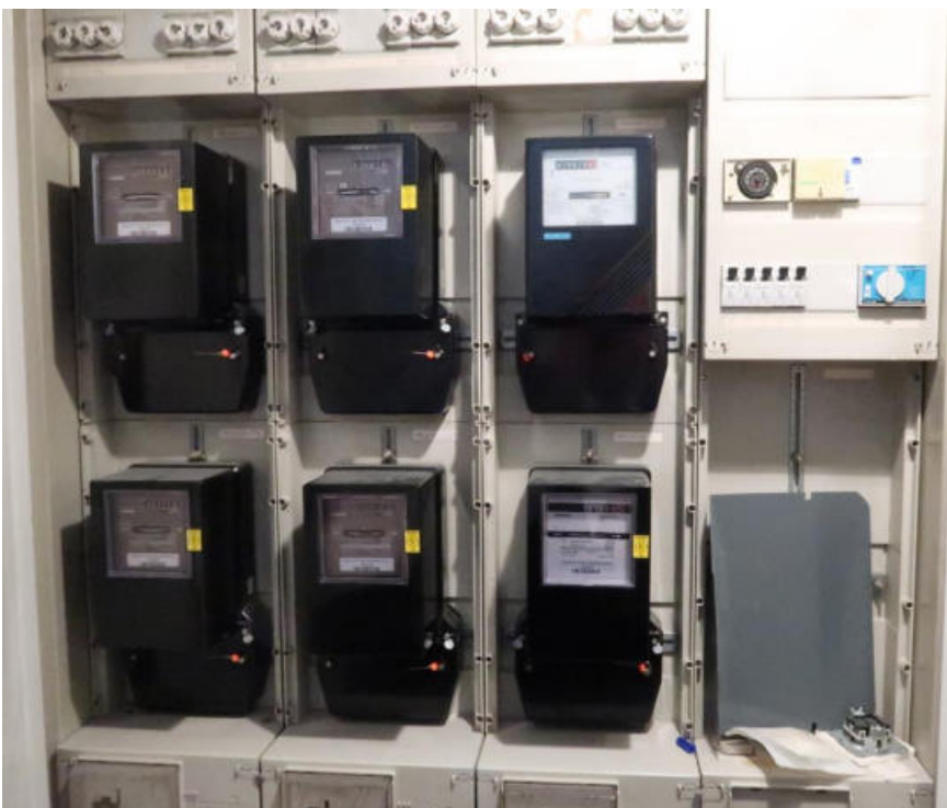
Elektro – Zählerschrank
