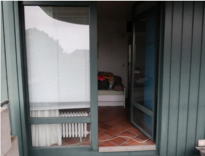
Zweiteiliges Fenster-/Türelement zum Balkon mit Flügeltür
