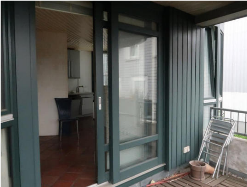
2-teiliges Fenster-/Türelement mit Schiebetür
