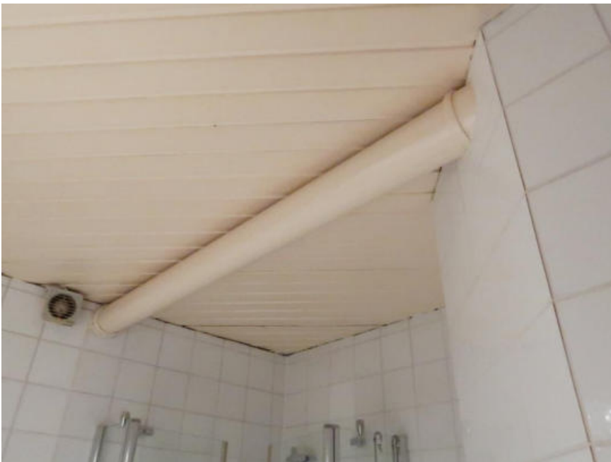
Entlüftung Bad, Rohrleitung zur Entlüftung Gäste-WC
