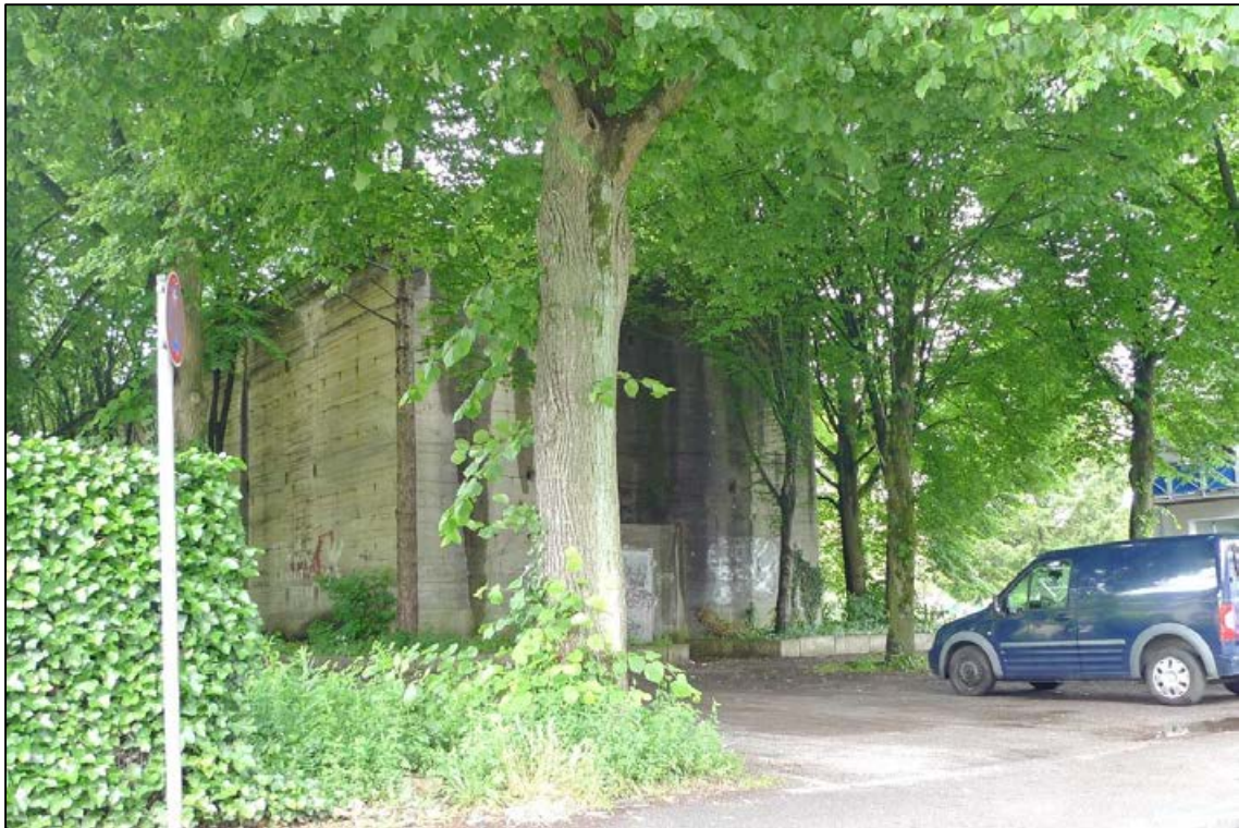
Abbildung 19 Zufahrt zum Haupteingang vom Luftschutzbunker fotografiert am 29.05.2024
