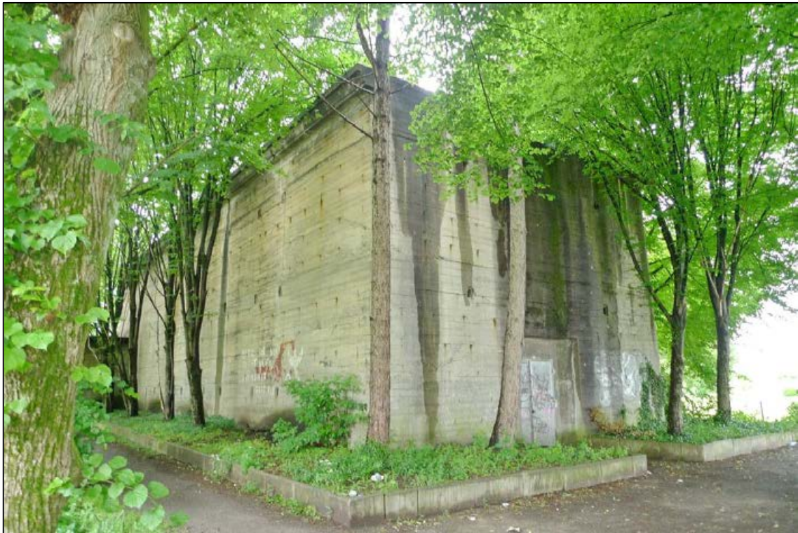
Abbildung 9 Straßen- und Seitenansicht vom Luftschutzbunker auf dem zu bewertenden Grundstück fotografiert am 29.05.2024
