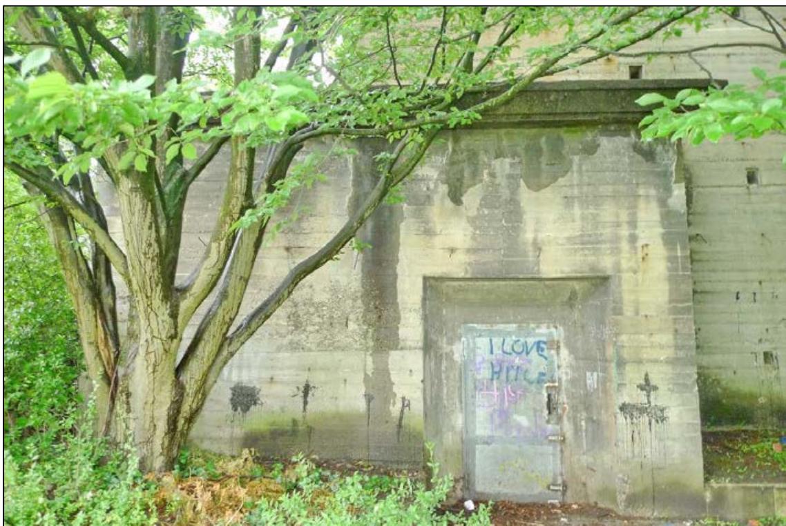
Abbildung 20 Seiteneingang vom Luftschutzbunker fotografiert am 29.05.2024
