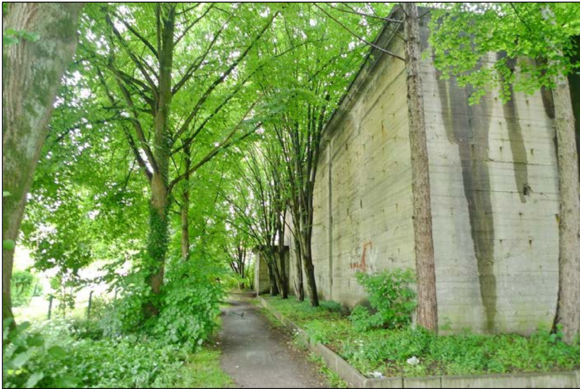
Abbildung 22 Fußweg südlich vom Luftschutzbunker auf dem zu bewertenden Grundstück fotografiert am 29.05.2024
