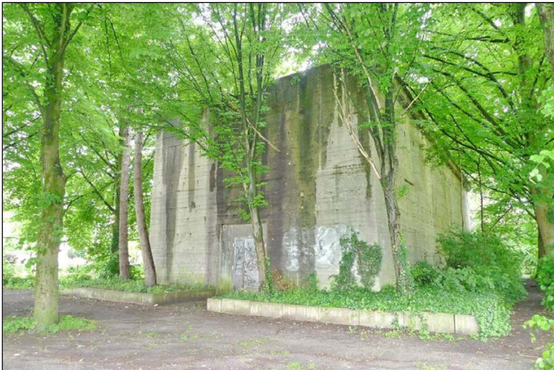
Abbildung 8 Straßen- und Seitenansicht vom Luftschutzbunker auf dem zu bewertenden Grundstück fotografiert am 29.05.2024
