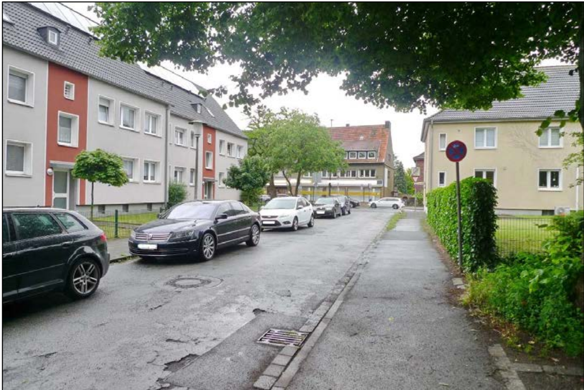
Abbildung 1 Umgebungsbebauung des zu bewertenden Grundstücks fotografiert am 29.05.2024
