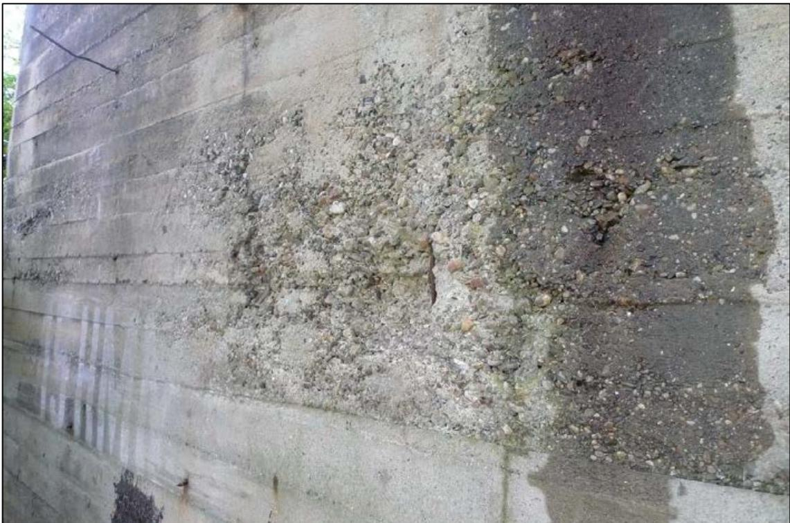
Abbildung 11 Betonschäden an den Wänden
