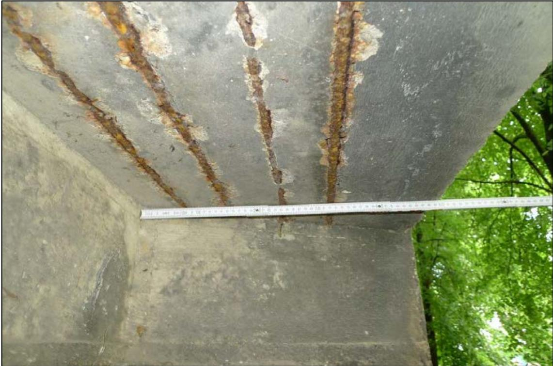
Abbildung 10 frei liegende Armierung an den Wänden
