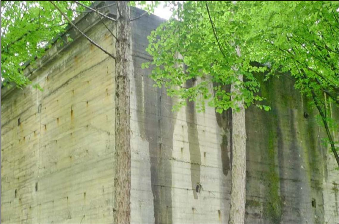
Abbildung 12 fehlendes Gesims sowie fehlende Dachrinnen und Fallrohre vom Luftschutzbunker auf dem zu bewertenden Grundstück fotografiert am 29.05.2024
