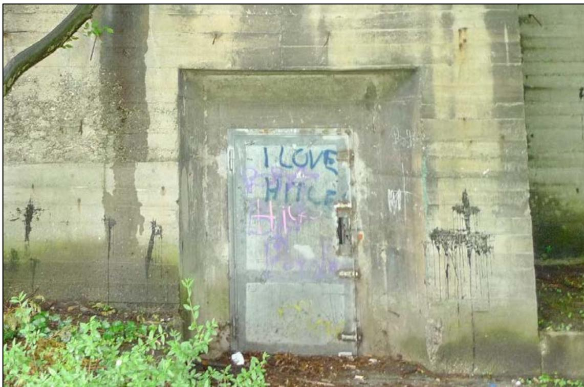
Abbildung 15 defekte Seiteneingangstür
