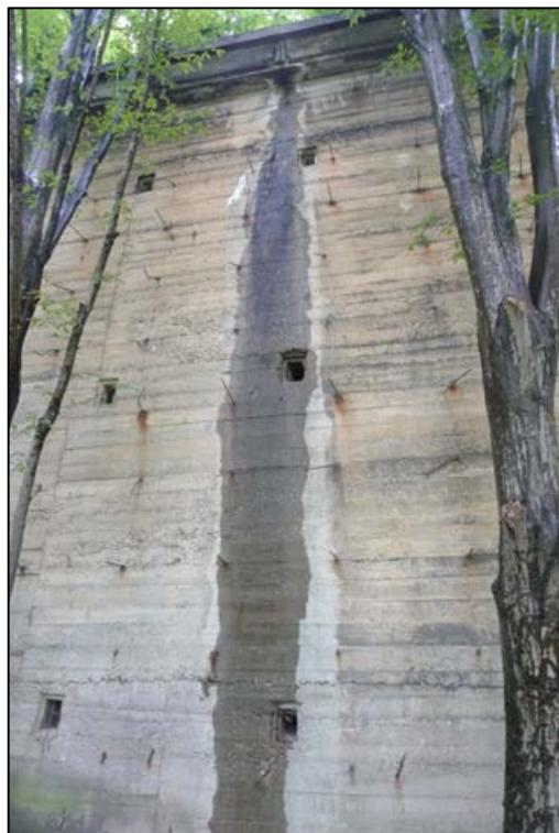
Abbildung 13 Betonschaden am Gesims vom Luftschutzbunker auf dem zu bewertenden Grundstück fotografiert am 29.05.2024
