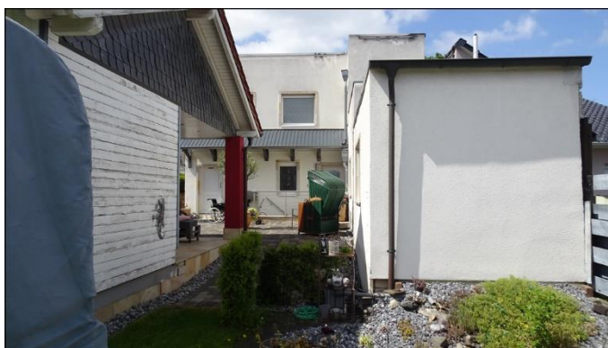
5) Teil- Rückansicht Haus und Nebengebäude
