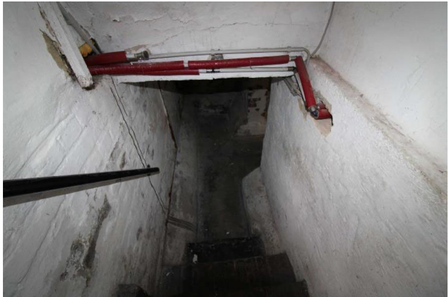
Sicht auf die Treppe zum Keller des zu bewertenden Objekts
