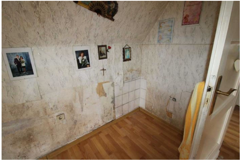
Sicht in den Raum 2 / DG
