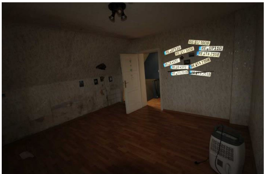
Sicht in den Raum 2 / DG
