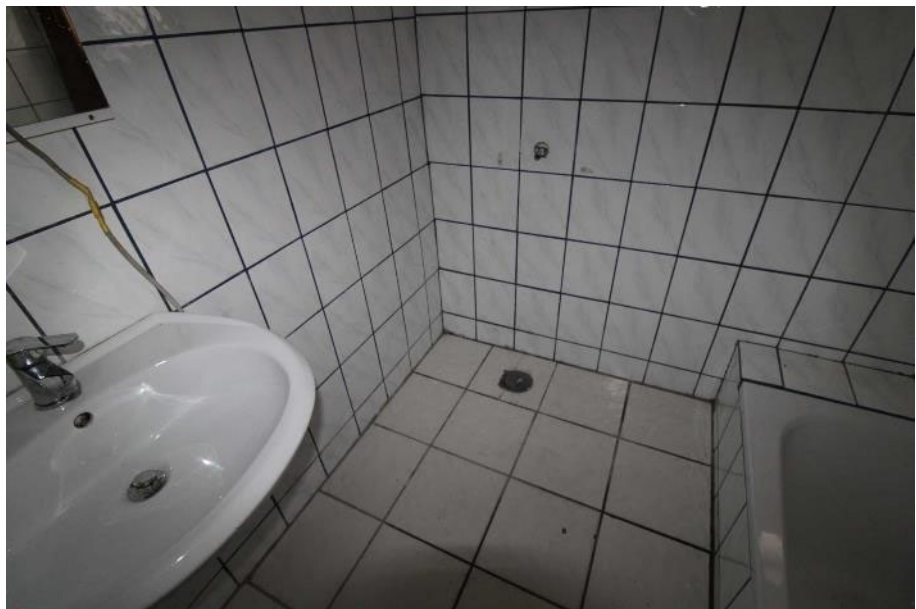
Sicht in das Bad (Anbau) / EG
