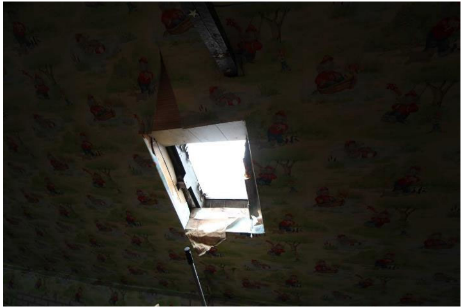
Sicht auf das Dachflächenfenster / SB
