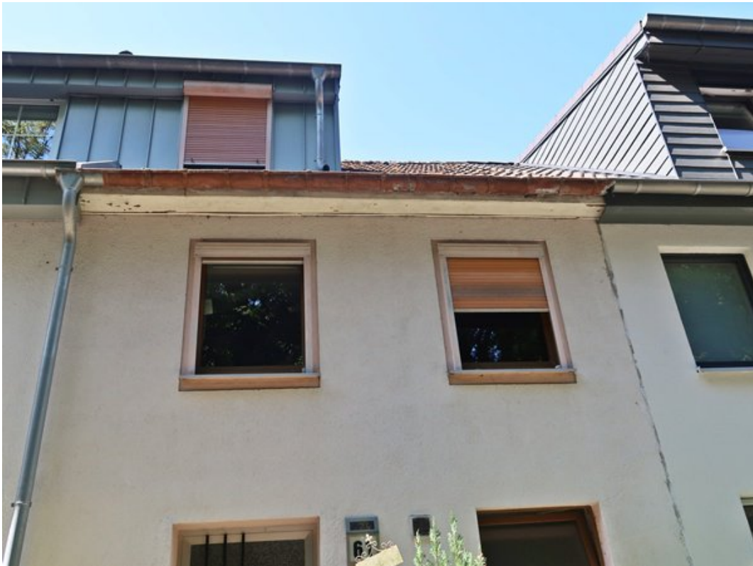
Instandsetzungsbedarf Dachrinne und Traufbekleidung
