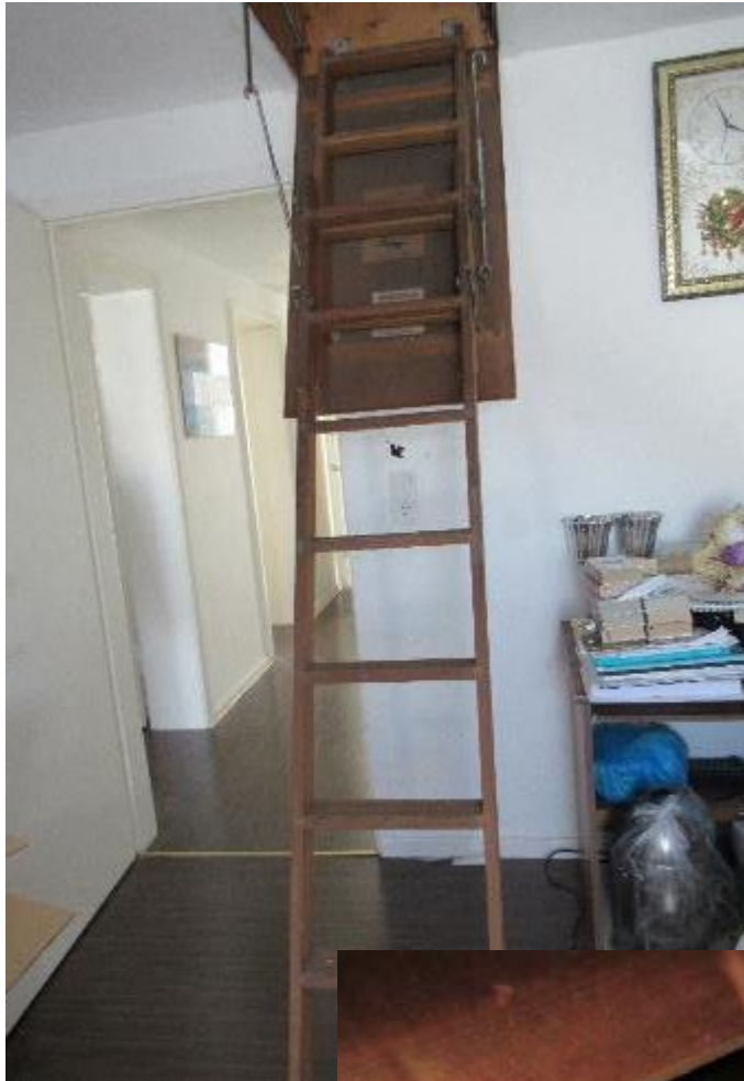
Treppe zum Spitzboden
