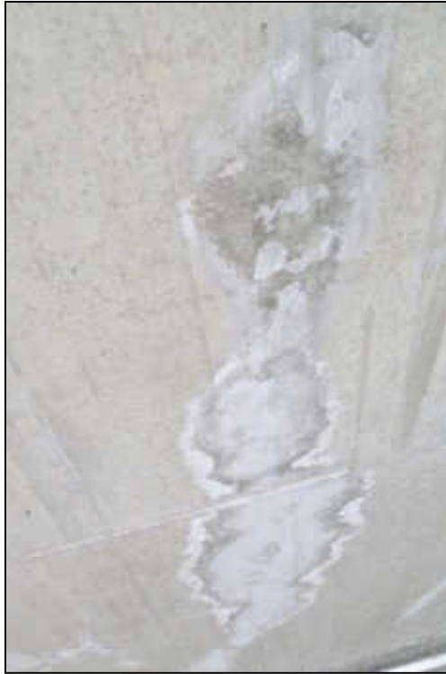
Abbildung 52 Feuchtigkeiterscheinungen und Ausblühungen an der Betondecke der Tiefgarage fotografiert am 17.06.2025
