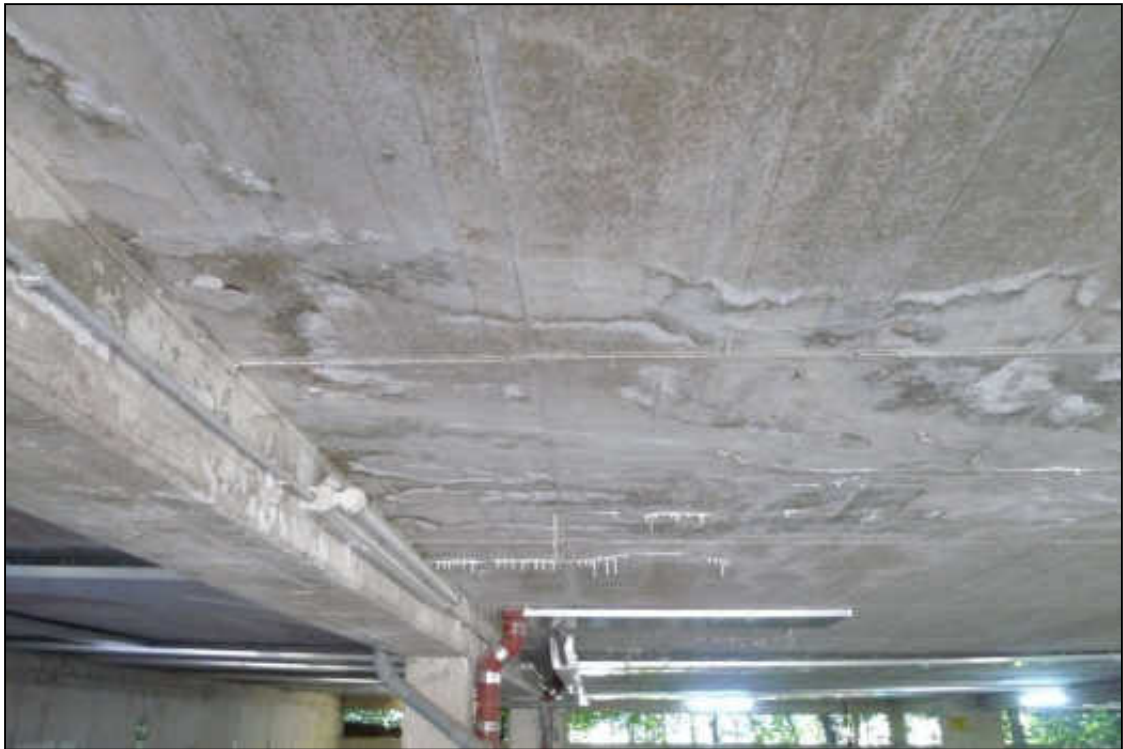
Abbildung 51 Feuchtigkeitserscheinung und Ausblühungen an der Betondecke der Tiefgarage fotografiert am 17.06.2025
