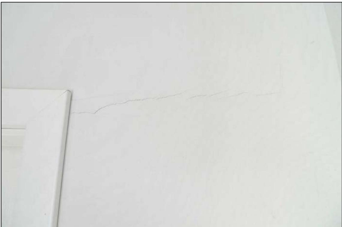
Abbildung 34 Rissbildungen an den Wänden im Obergeschoss
