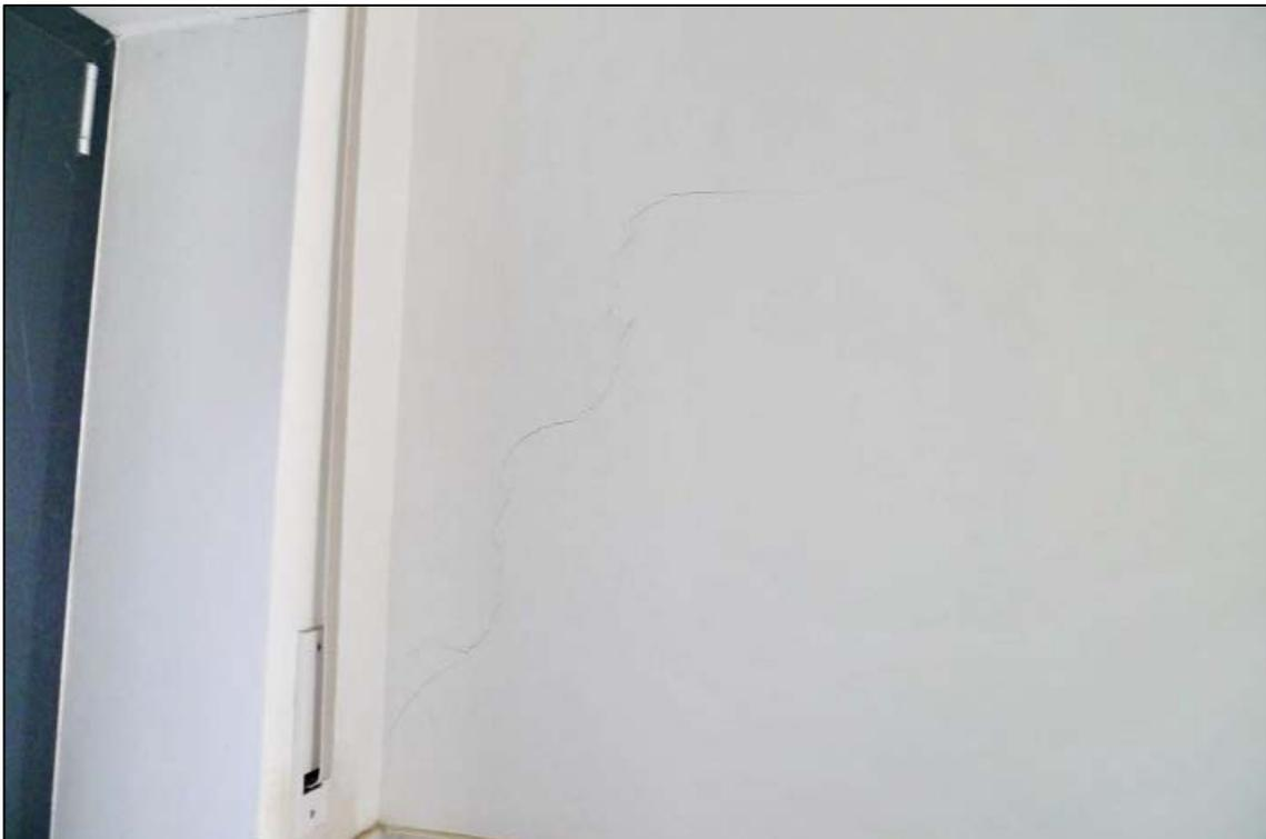
Abbildung 30      Rissbildungen an den Wänden im Erdgeschoss
