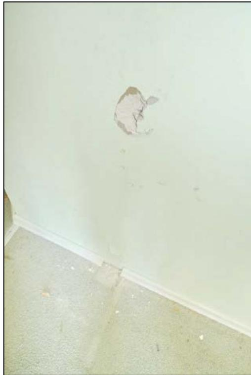
Abbildung 35 Beschädigungen der Wände im Obergeschoss vom Einfamilienhaus auf dem zu bewertenden Grundstück fotografiert am 14.05.2024
