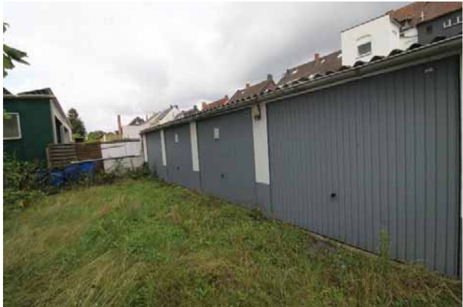
Sicht auf die Zufahrt zu den hinteren vier Pkw-Garagen der Garagenanlage des zu bewertenden Objekts
