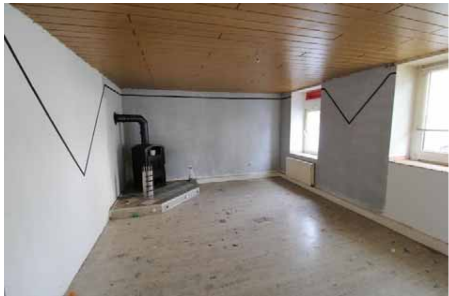
Sicht in den Raum 2 / EG links
