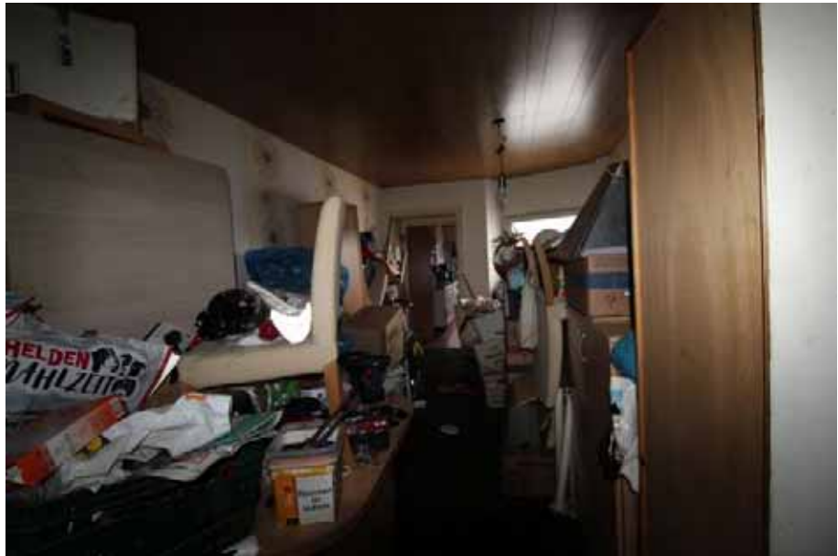
Sicht in den Raum 1 / 1. OG rechts
