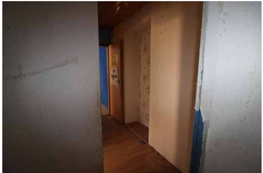
Sicht in einen Flur / EG links
