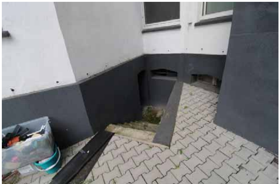
Sicht auf eine Keller- ausgangstreppe des zu bewertenden Ob- jekts
