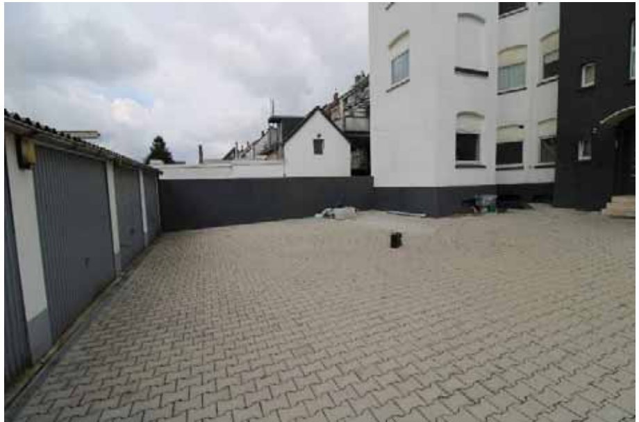
Sicht auf die gepflasterte Hoffläche des zu bewertenden Objekts
