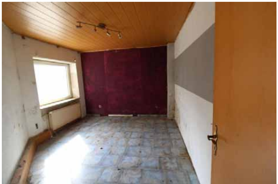
Sicht in den Raum 1 / EG links
