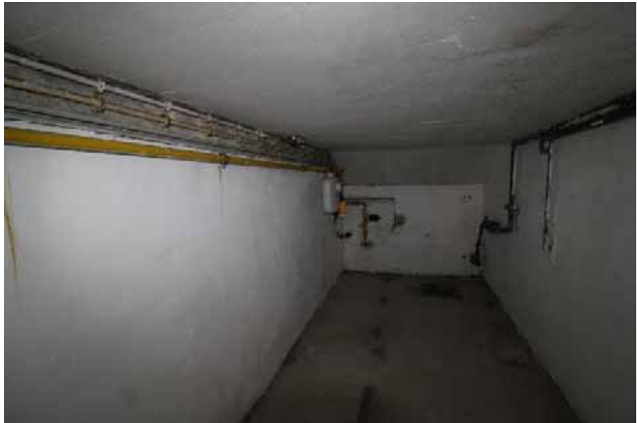
Sicht in einen Keller- raum mit Hausan- schlüssen / KG
