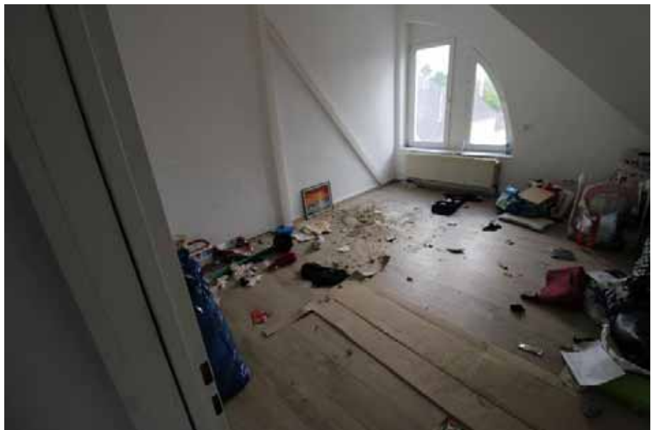
Sicht in den Raum 2 / DG rechts
