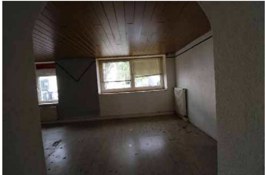
Sicht in den Raum 2 / EG links
