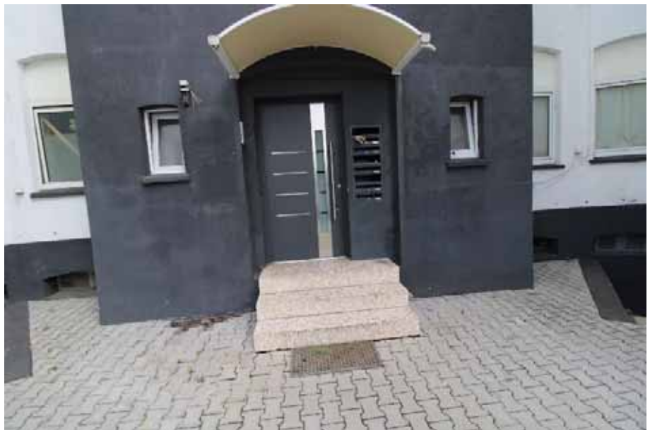
Sicht vom Hof aus auf den Hausein- gangsbereich an der Rückansicht des zu bewertenden Objekts
