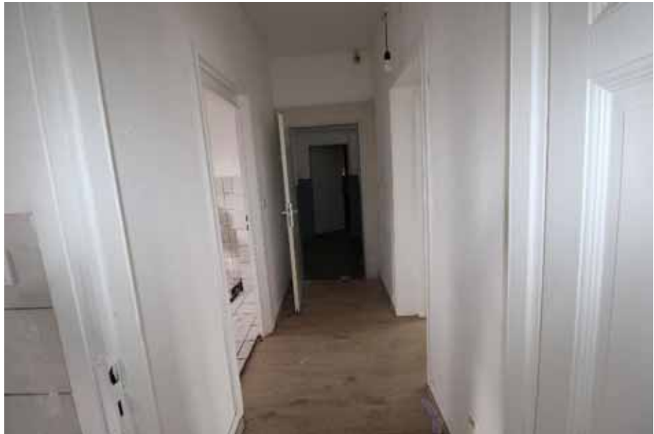
Sicht in den Flur / DG rechts
