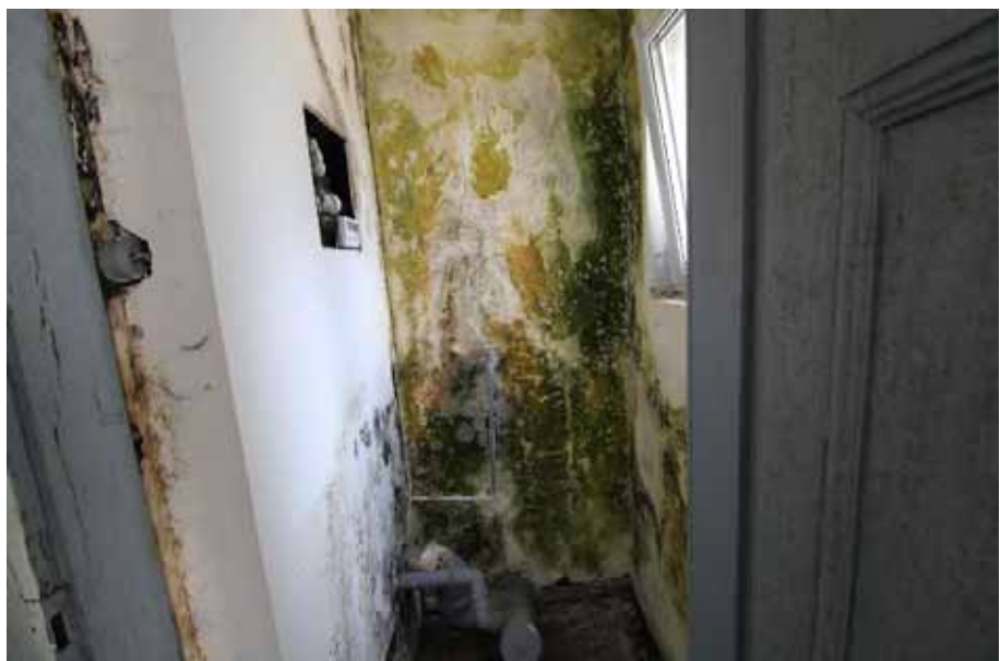
Sicht in eine Kammer auf den Zwischenpodesten im Treppenhaus / EG
