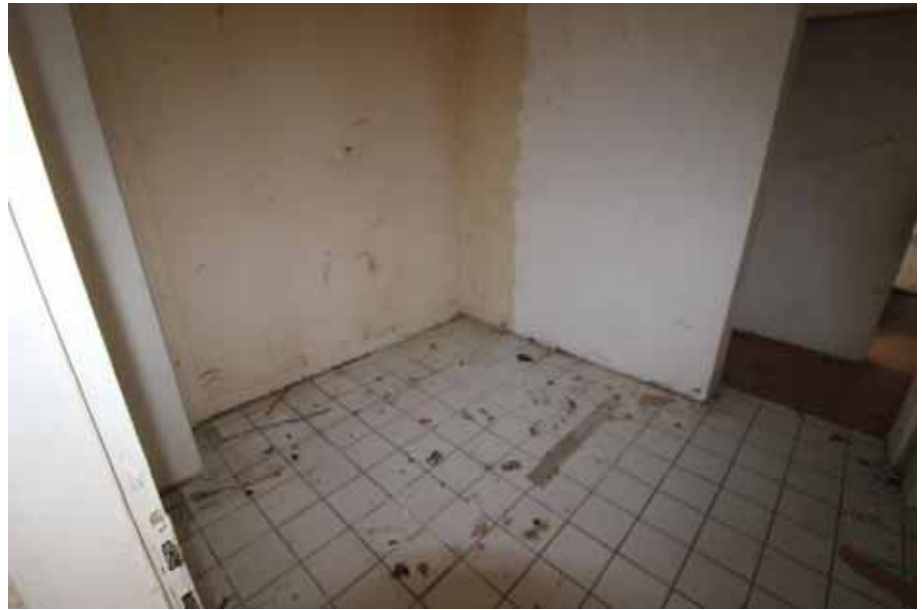
Sicht in einen Raum / EG links
