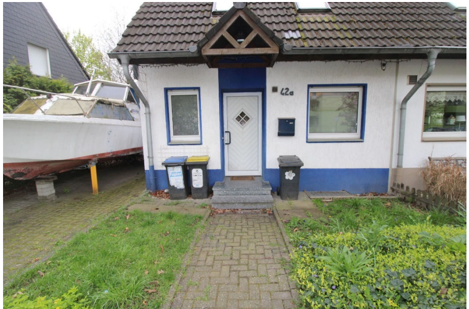
Sicht vom Gehweg aus auf die Vorderfas- sade des Wohnhau- ses und den Hausein- gang
