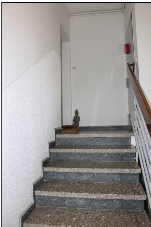
Foto Nr. 18: Forellstraße 61, Gemeinschaftstreppehaus DG
