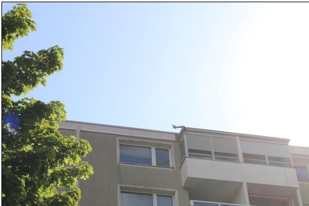
Foto Nr. 2: Straßenfassade, Forellstraße 61, 7. OG
