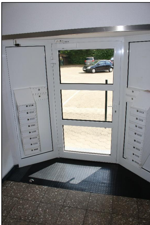
Foto Nr. 10: Forellstraße 61, Hauseingang
