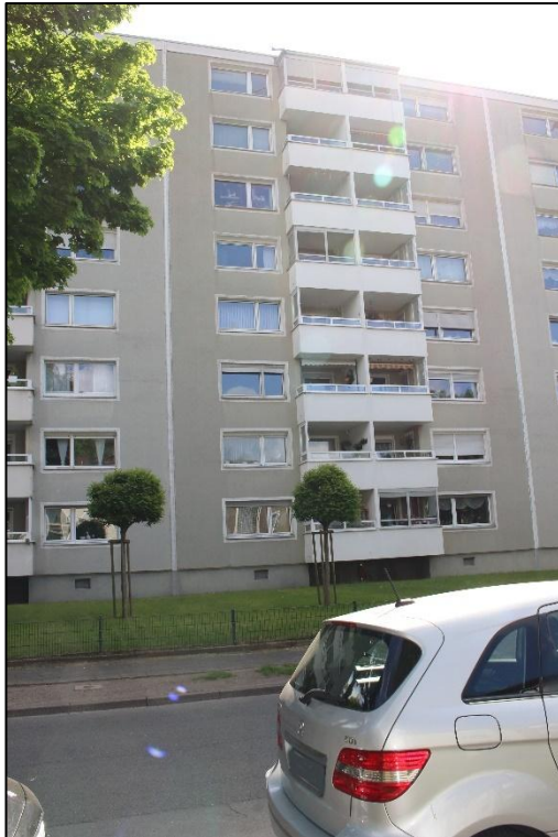
Foto Nr. 1: Straßenfassade, Forellstraße 61
