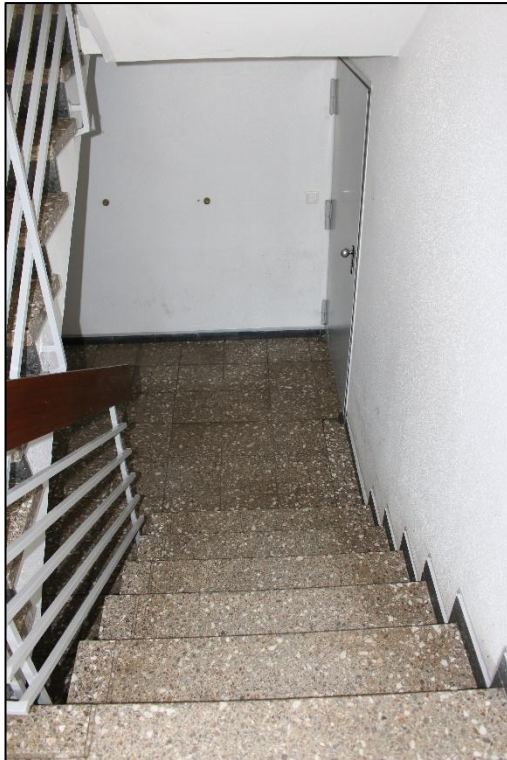
Foto Nr. 11: Forellstraße 61, Treppe zum Kellergeschoss
