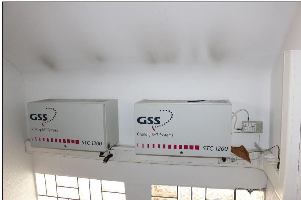
Foto Nr. 19: Forellstraße 61, Gemeinschaftstreppehaus DG
