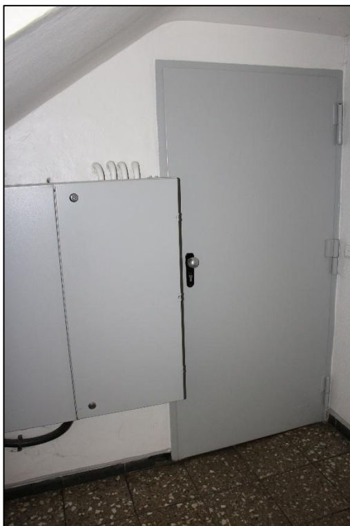
Foto Nr. 12: Forellstraße 61, Kellergeschoss, Treppenhaus
