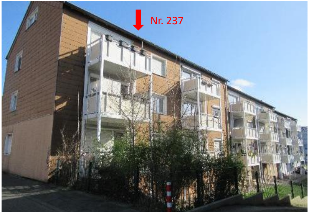
Straßenansicht Bochumer Straße 237, 237a, 237b
