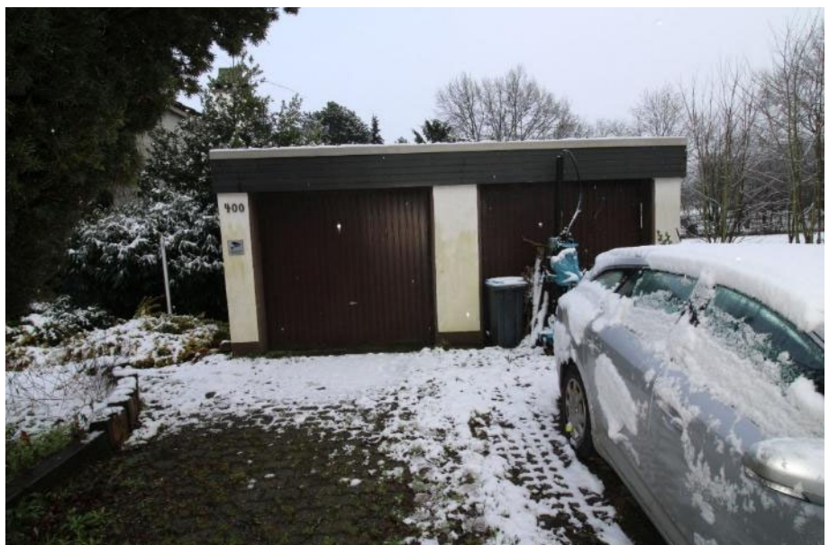
Sicht auf die Doppel- garage und die Frei- fläche davor.
