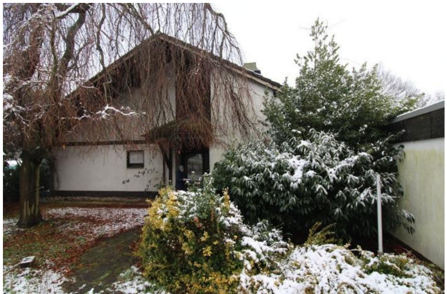
Sicht auf die Vorderfassade des Wohnhauses.
