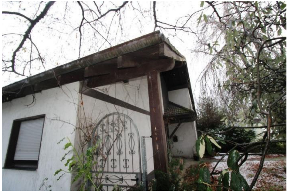
Sicht auf die Vorder- und Seitenfassade links des Wohnhau- ses.
