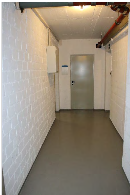
Foto Nr. 28: Langenbochumer Straße 453, Kellergeschoss, Flur
