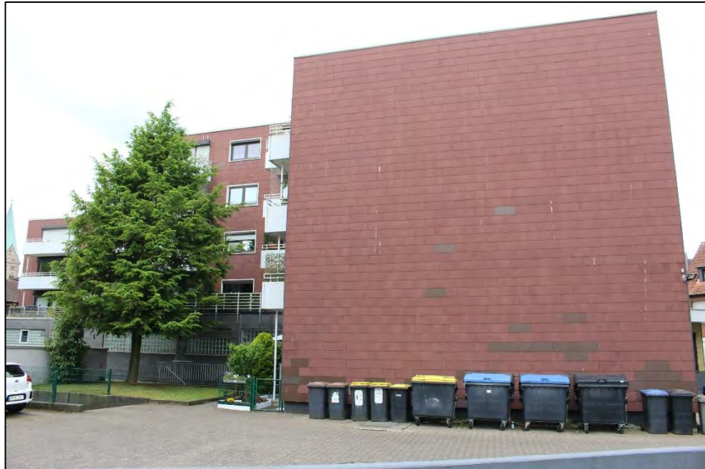
Foto Nr. 3: Seitenfassade
