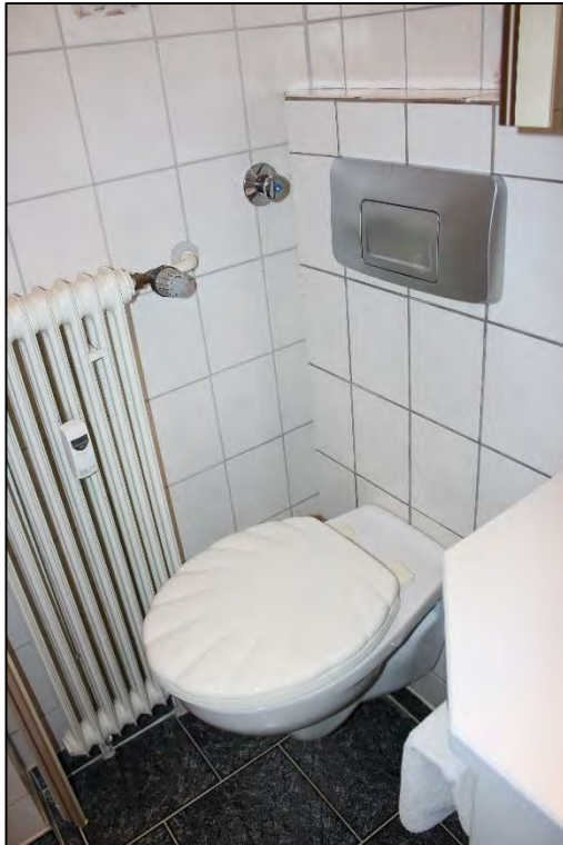
Foto Nr. 19: Langenbochumer Straße 453, 2. OG, ETW Nr. 17, Bad
