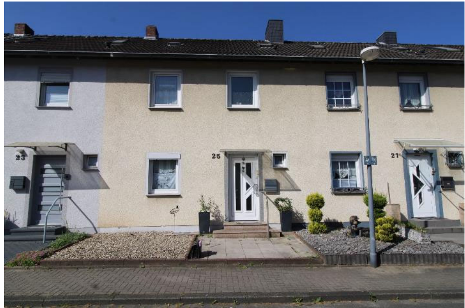
Sicht von der Imbuschstraße aus auf die Vorderseite des zu bewertenden Objekts
