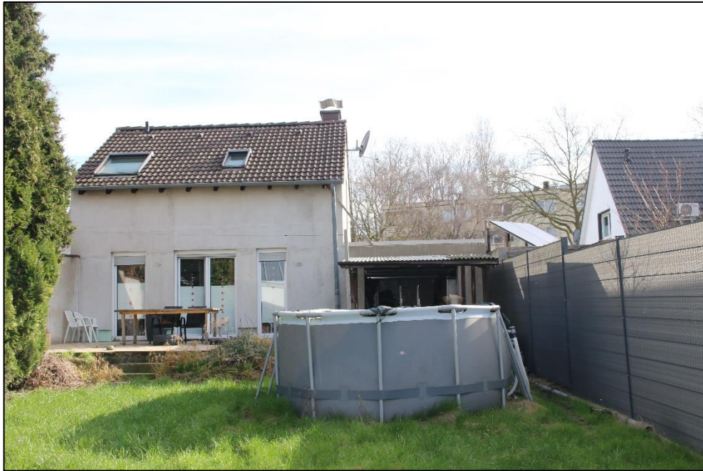
Foto Nr. 7: Gartenfassade / Gartenanlage
