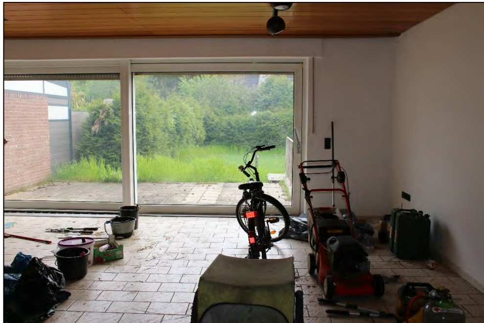
Foto Nr. 33: Erdgeschoss, Wohn- und Esszimmer
