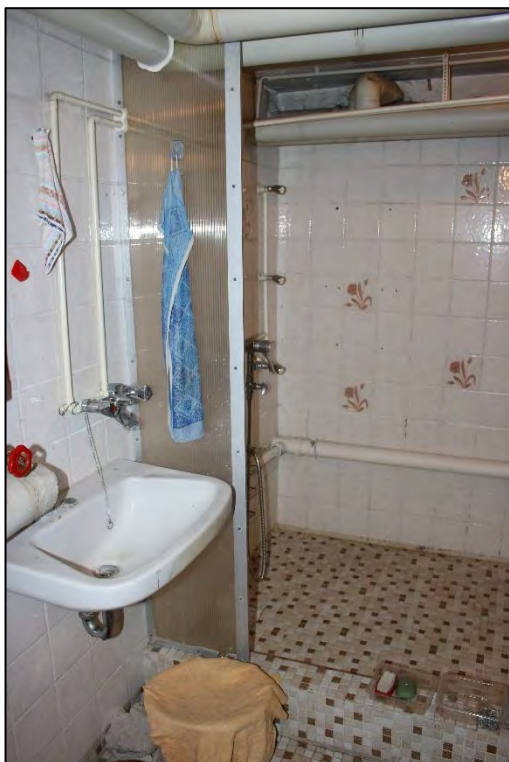
Foto Nr. 18: Kellergeschoss, Heizungsraum
