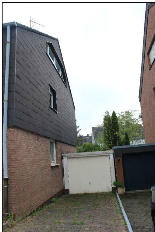
Foto Nr. 2: Seitenfassade
