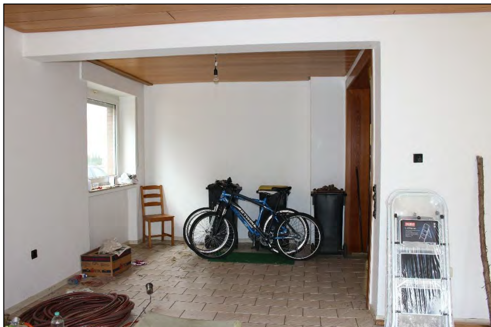
Foto Nr. 32: Erdgeschoss, Wohn- und Esszimmer
