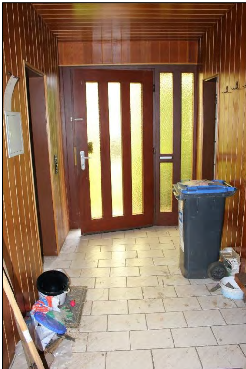
Foto Nr. 14: Erdgeschoss, Eingangsbereich
