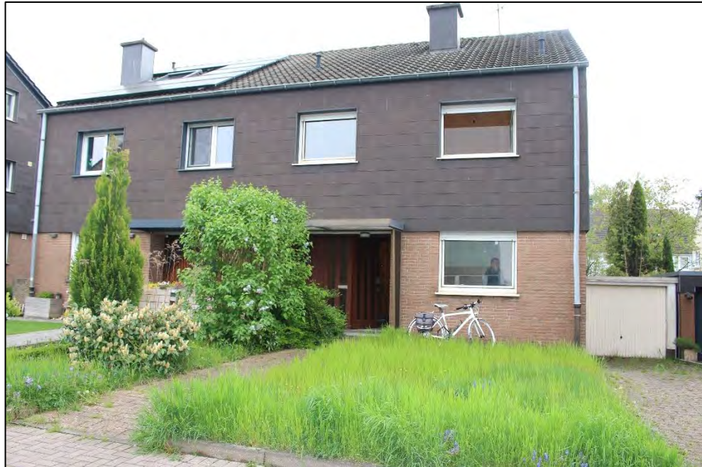
Foto Nr. 1: Straßenfassade
