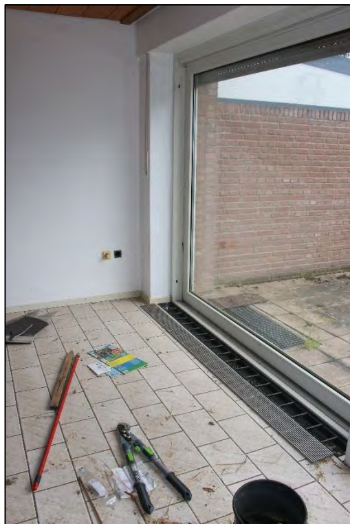
Foto Nr. 34: Erdgeschoss, Wohn- und Esszimmer
