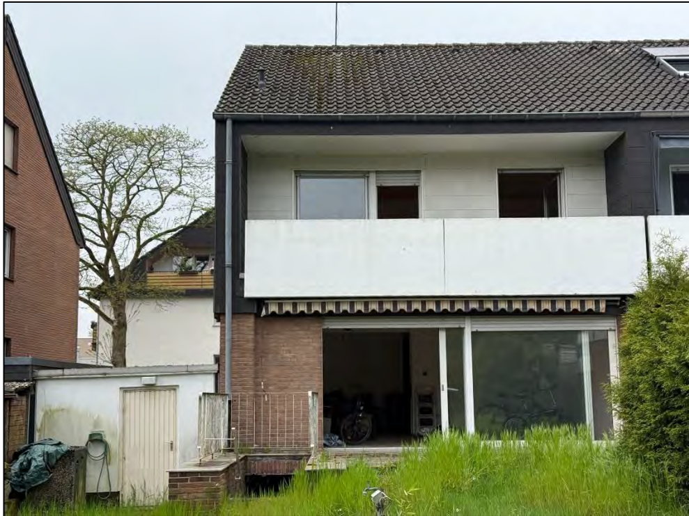
Foto Nr. 7: Gartenfassade
