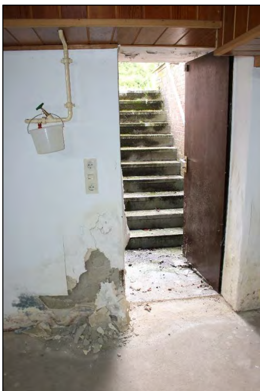
Foto Nr. 26: Kellergeschoss, Kelleraußeneingang
