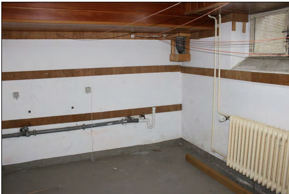
Foto Nr. 21: Kellergeschoss, Kellerraum
