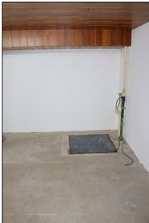
Foto Nr. 24: Kellergeschoss, Kellerraum
