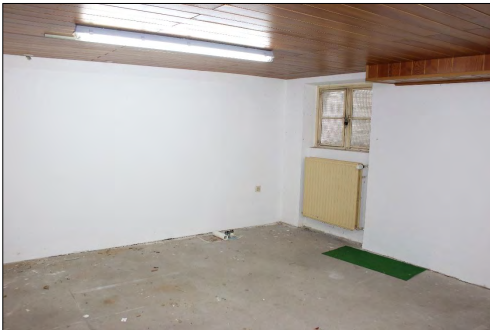
Foto Nr. 25: Kellergeschoss, Kellerraum
