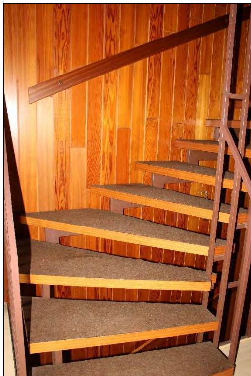
Foto Nr. 44: Obergeschoss, Treppe zum Dachgeschoss
