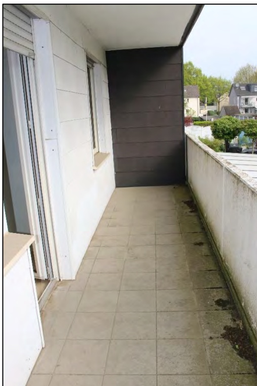
Foto Nr. 38: Obergeschoss, Balkon
