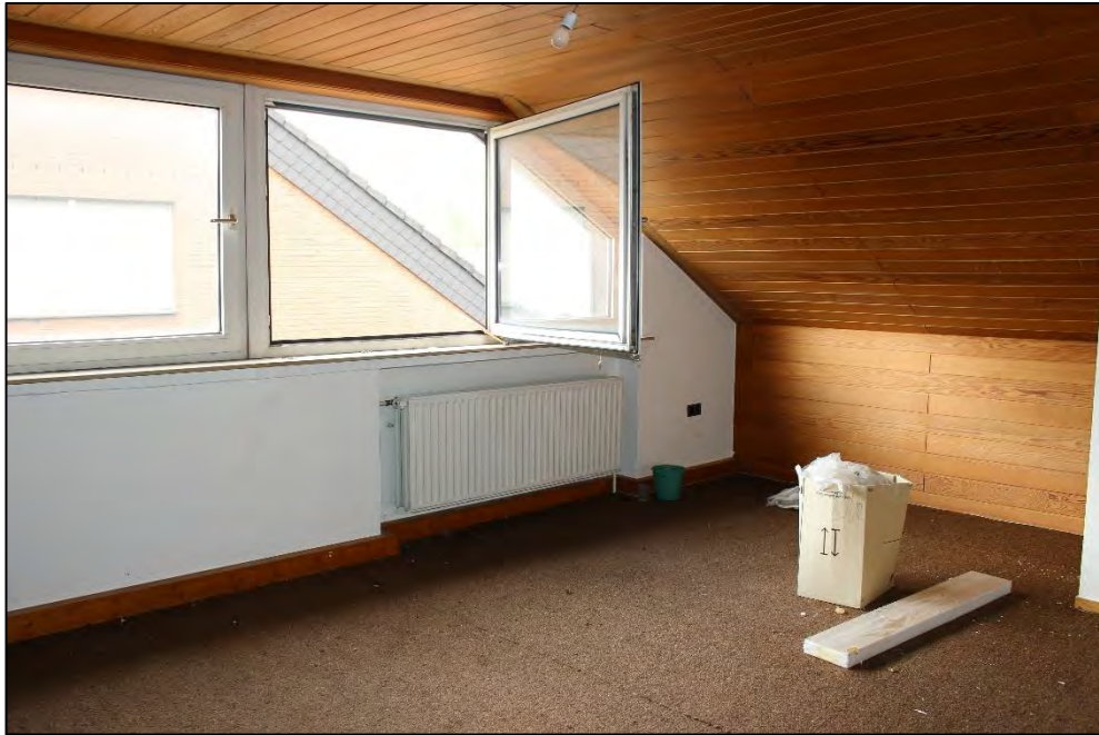
Foto Nr. 45: Dachgeschoss, ausgebauter Raum
