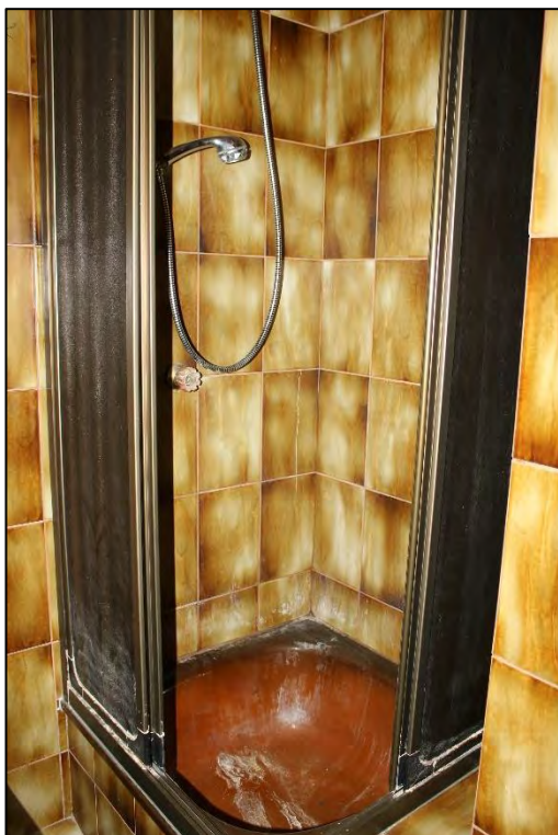
Foto Nr. 42: Obergeschoss, Badezimmer
