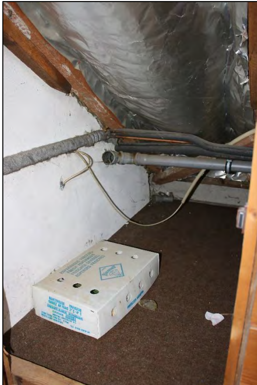
Foto Nr. 49: Dachgeschoss, Abstellfläche
