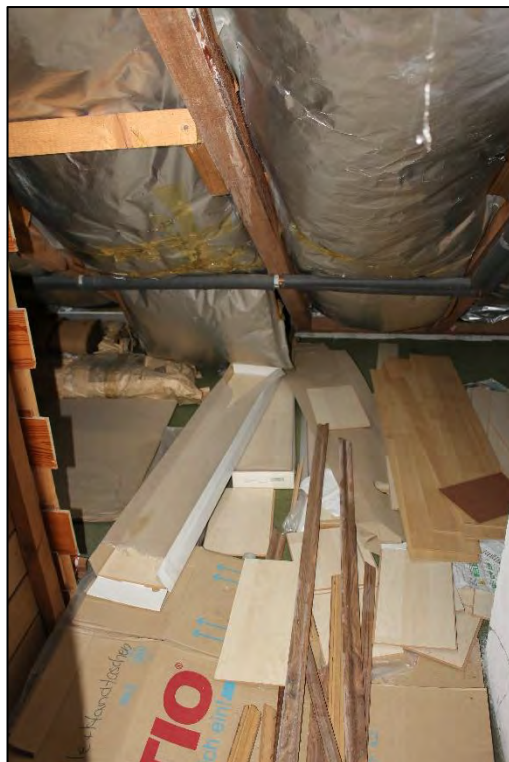
Foto Nr. 48: Dachgeschoss, Abstellfläche
