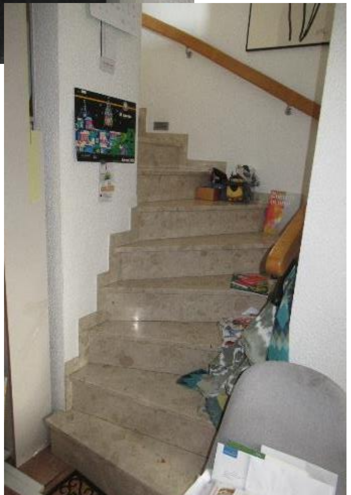
Treppe zum Dachgeschoss
