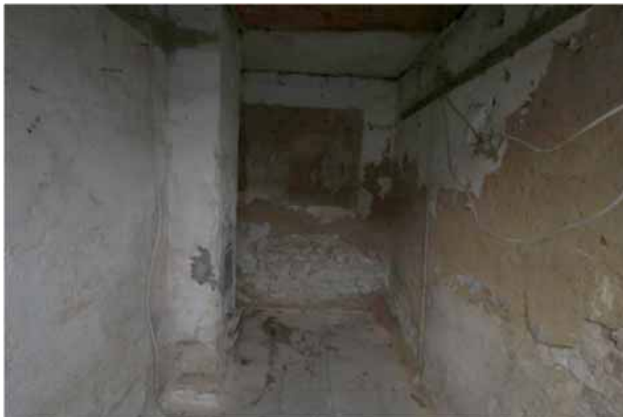
Sicht in den hinteren Raum im Anbau
