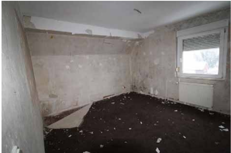
Sicht in das Zimmer 2 / DG
