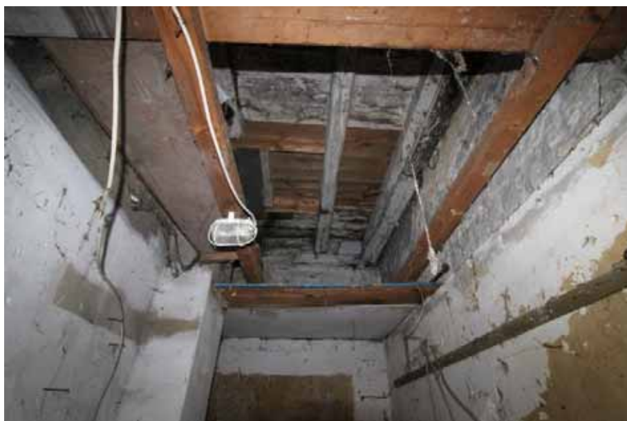
Sicht in den hinteren Raum im Anbau
