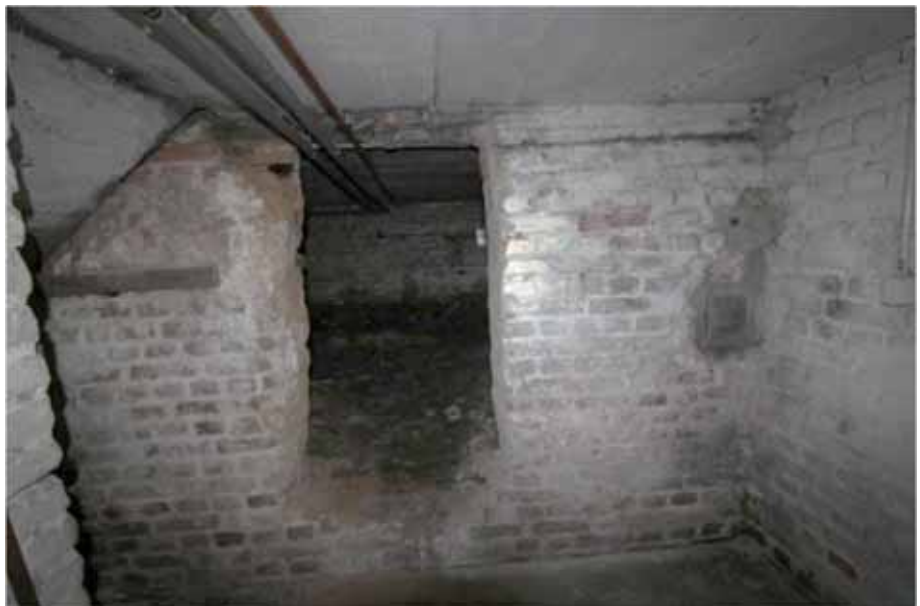
Sicht vom Kellerraum aus auf den Zugang zum Kriechkeller / KG
