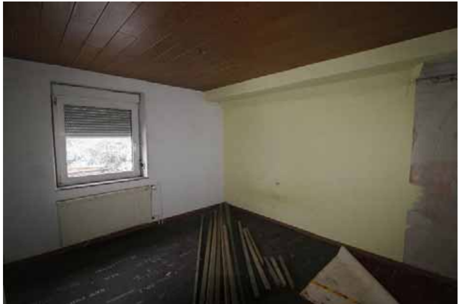
Sicht in das Zimmer 1 / DG
