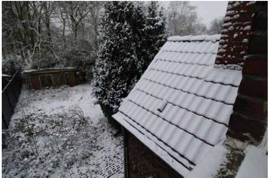
Sicht vom Zimmer 1 aus hinten heraus / DG
