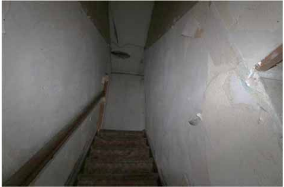
Sicht auf die interne Treppe / DG
