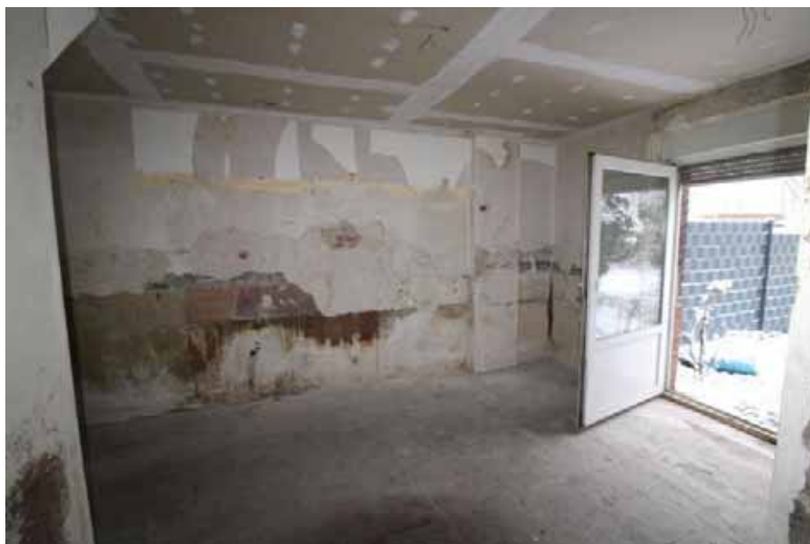
Sicht in die Essküche / EG
