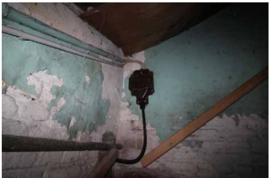
Sicht auf den Haupt- stromanschluss / KG
