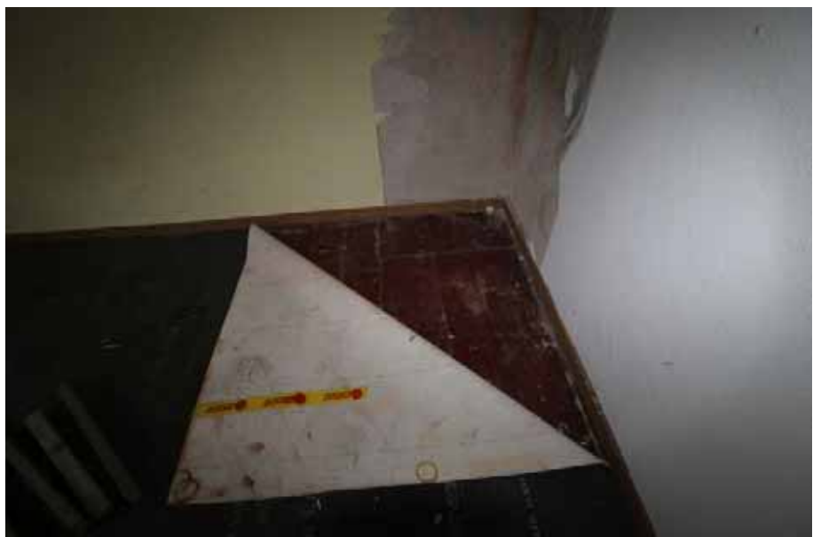
Sicht in das Zimmer 1 / DG
