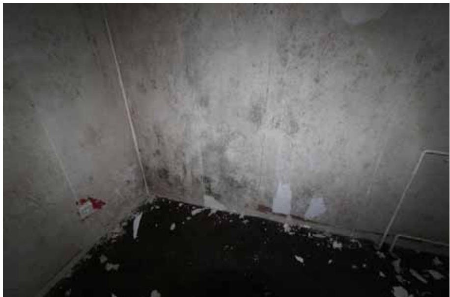
Sicht in das Zimmer 2 / DG
