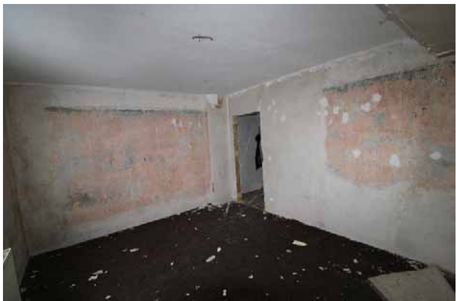
Sicht in das Zimmer 2 / DG
