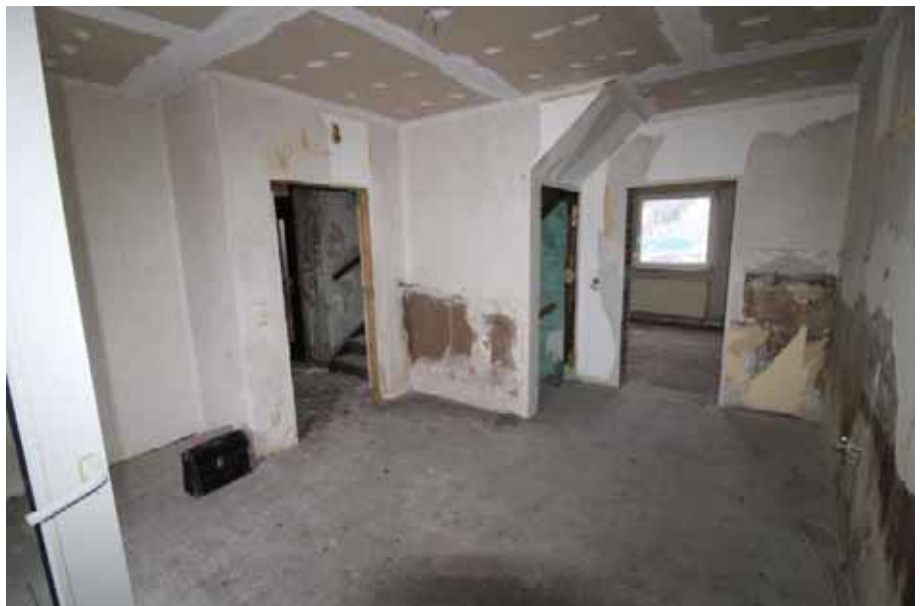
Sicht in die Essküche / EG
