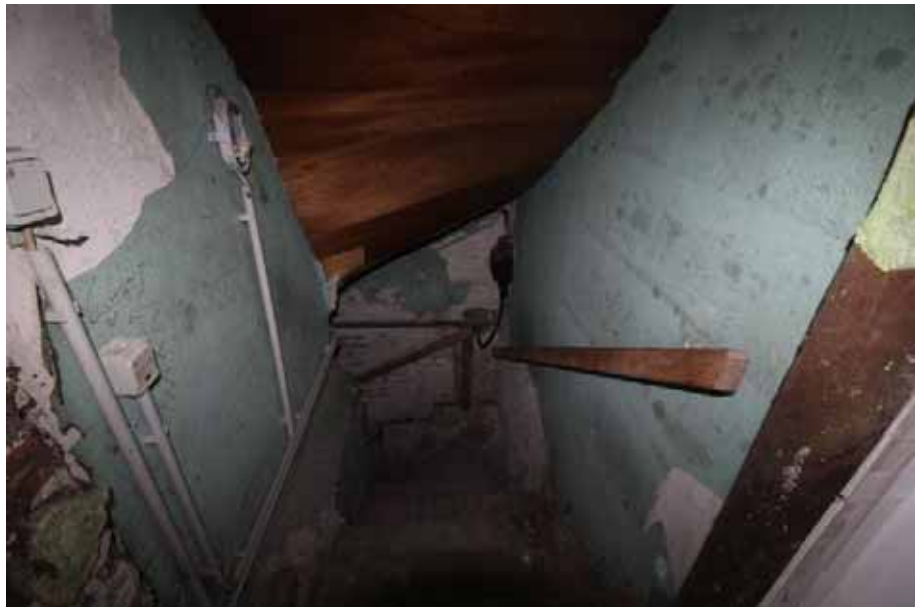
Sicht von der Ess- küche aus auf den Kellerabgang / EG
