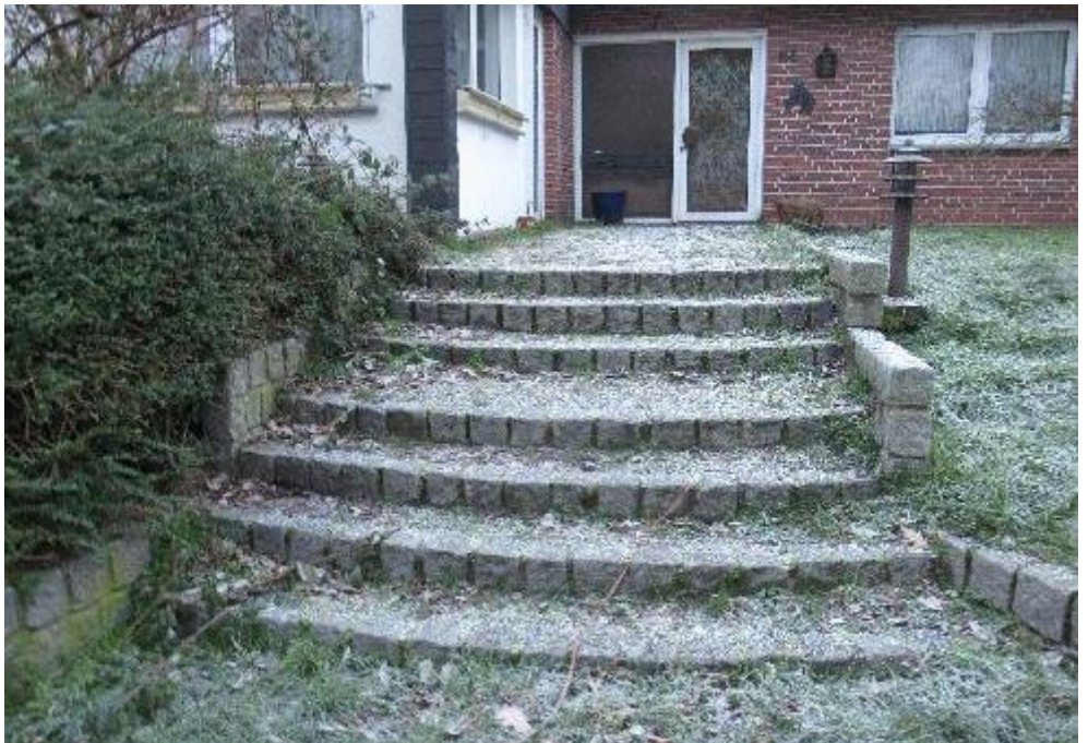
Stufenanlage zur Eingangstür
