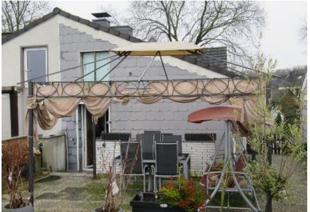
Gartenansicht des Anbaus
