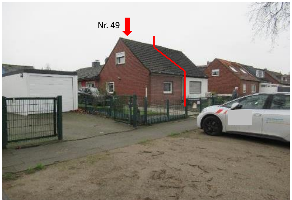
Straßenansicht Berghäuser Straße 47 bis 55
