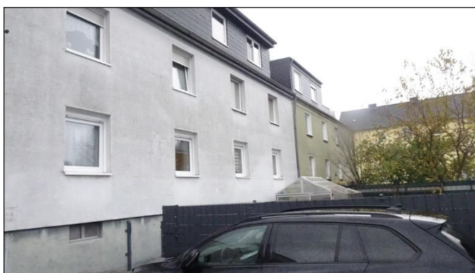
11) Rückansicht vom Nachbargrundstück
