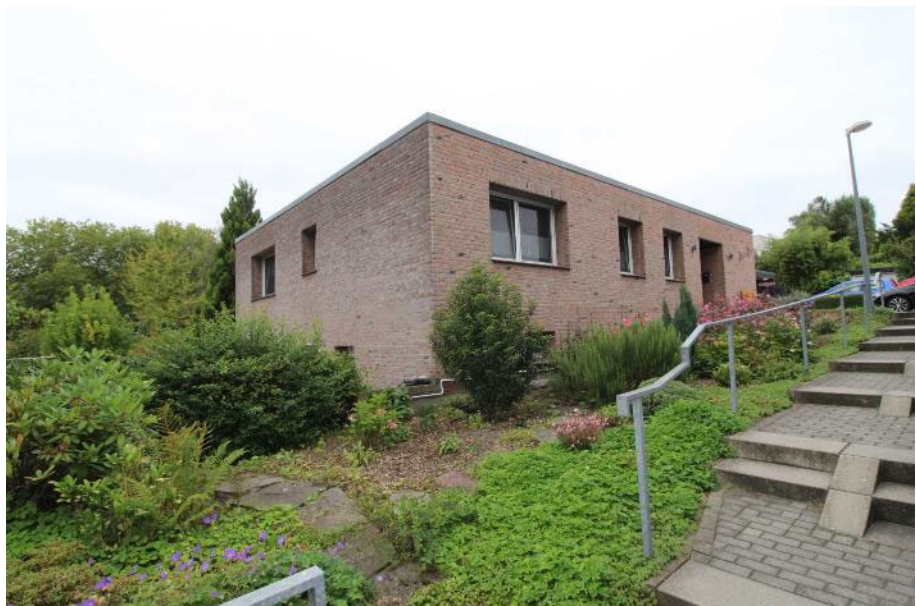
Sicht von der öffentlichen Zuwegung auf die Vorder- und linke Gebäudeseite des zu bewertenden Objekts
