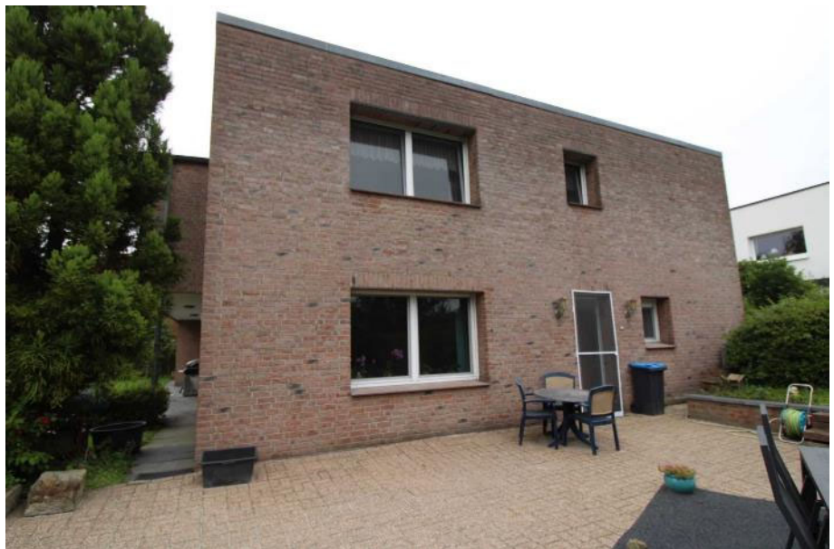
Sicht auf die linke Gebäudeseite des zu bewertenden Objekts
