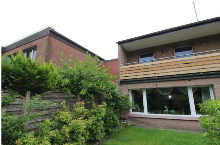
Sicht vom Garten aus auf einen Teil der Rückansicht des zu bewertenden Objekts
