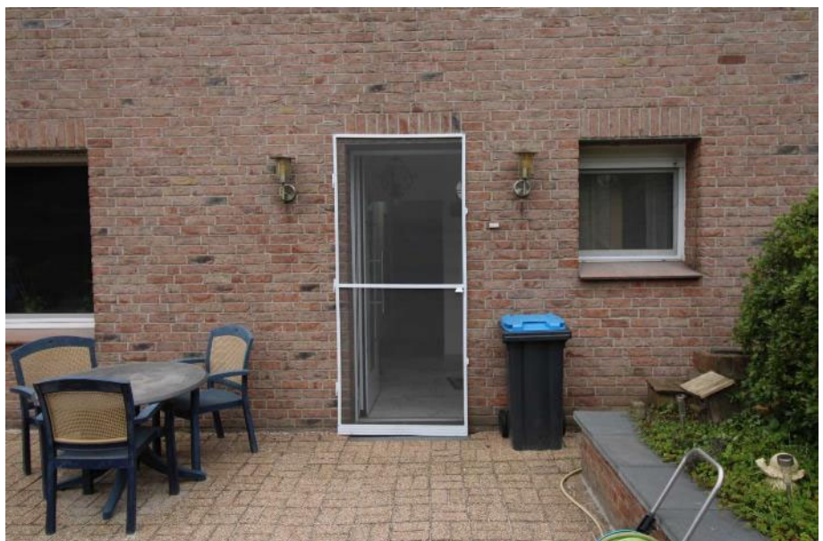
Sicht auf den Zugang zum Untergeschoss des zu bewertenden Objekts
