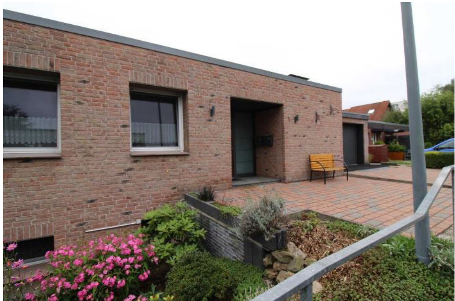
Sicht von der öffentlichen Zuwegung auf den Hauseingangsbereich des zu bewertenden Objekts
