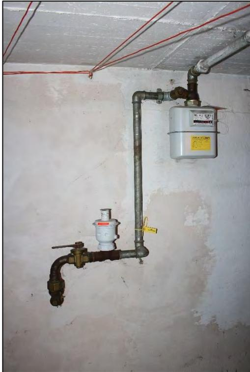
Foto Nr. 23: Kellergeschoss, Gashausanschluss / Gaszähler
