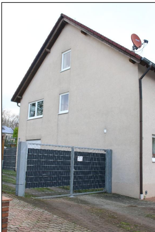
Foto Nr. 4: Doppelhaushälfte links, Ehlingstraße 55, Seitenfassade, Zufahrt
