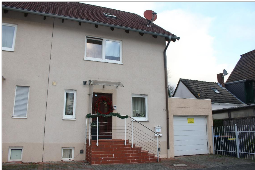
Foto Nr. 2: Doppelhaushälfte rechts, Ehlingstraße 57, Straßenfassade
