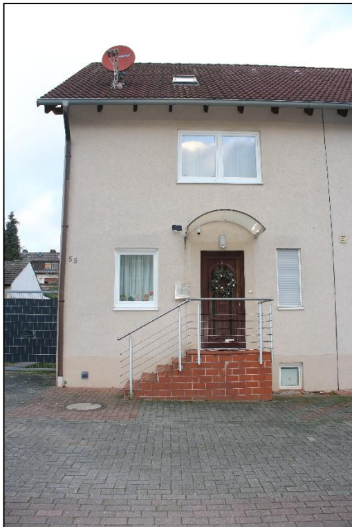
Foto Nr. 3: Doppelhaushälfte links, Ehlingstraße 55, Straßenfassade
