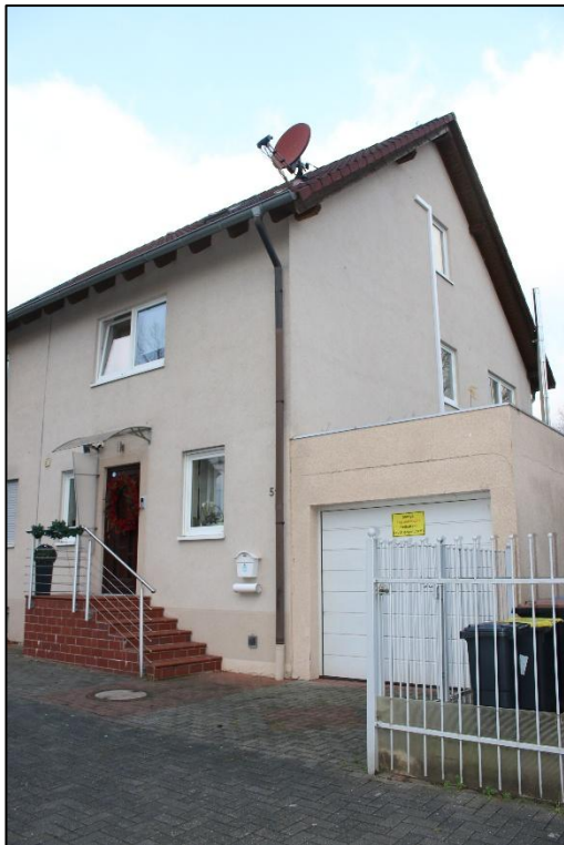
Foto Nr. 5: Doppelhaushälfte rechts, Ehlingstraße 57, Seitenfassade, Garage
