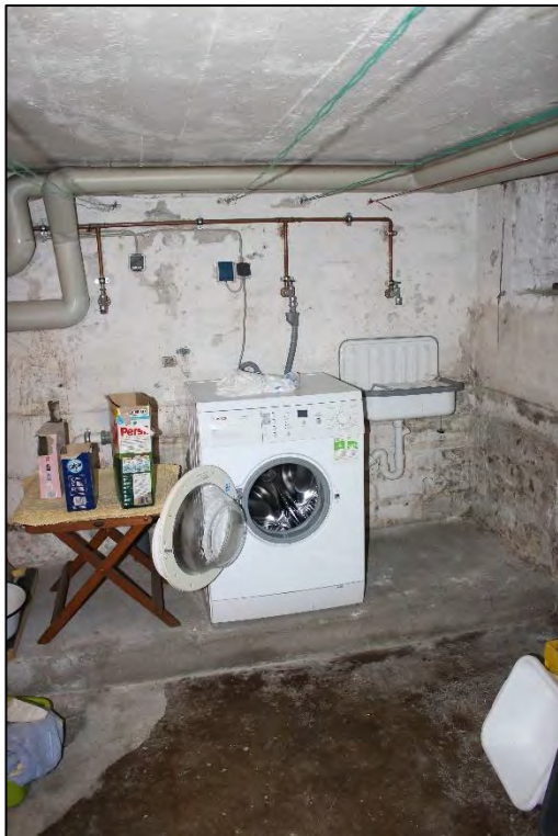
Foto Nr. 15: Kellergeschoss, Waschküche / Heizungsraum
