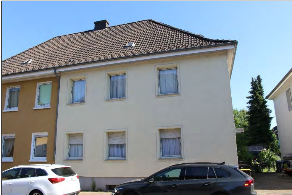
Foto Nr. 1: Straßenfassade
