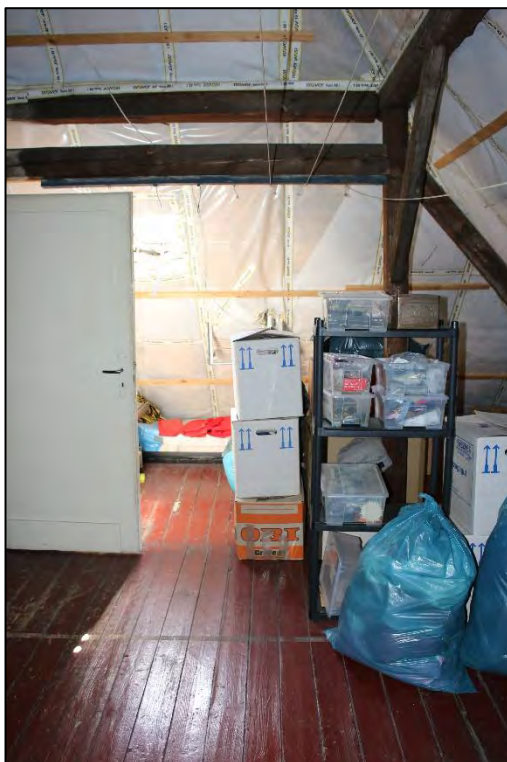
Foto Nr. 44: Dachgeschoss, Bodenraum 1
