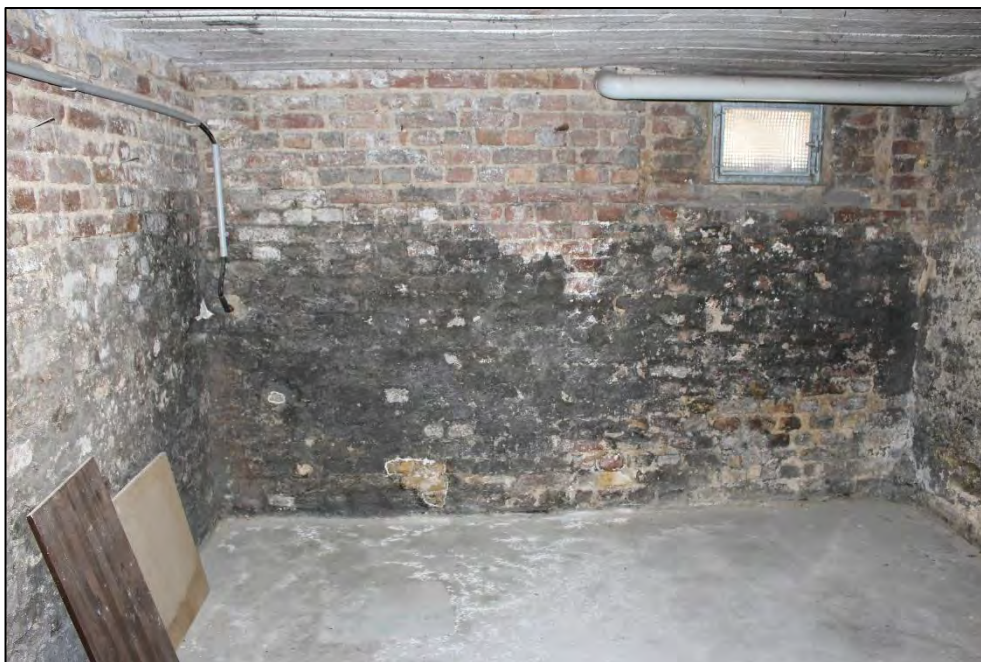
Foto Nr. 17: Kellergeschoss, Kellerraum
