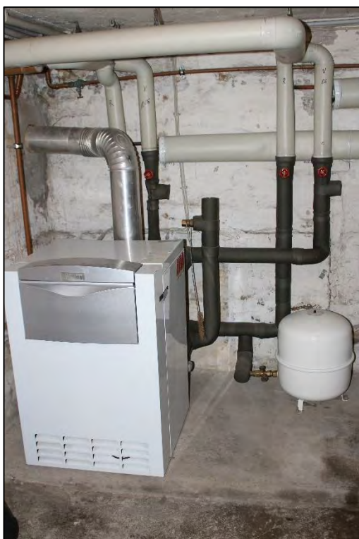
Foto Nr. 16: Kellergeschoss, Waschküche / Heizungsraum
