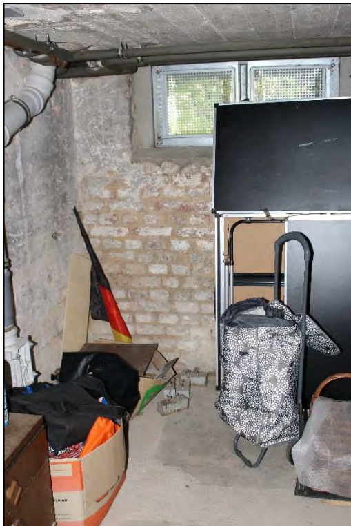
Foto Nr. 13: Kellergeschoss, Kellerraum
