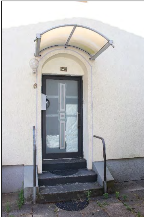
Foto Nr. 3: Hauseingang
