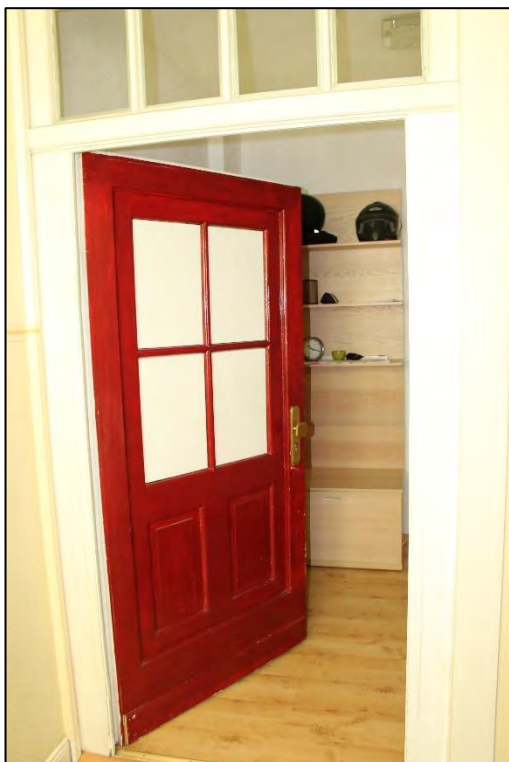
Foto Nr. 32: Gemeinschaftstreppenhaus, 1. OG, Eingang WE Nr. 2
