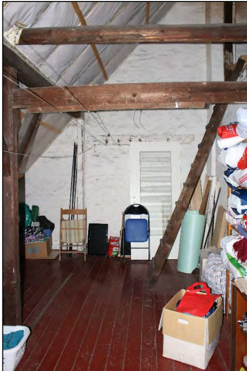
Foto Nr. 43: Dachgeschoss, Bodenraum 1
