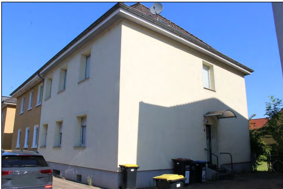
Foto Nr. 2: Seitenfassade
