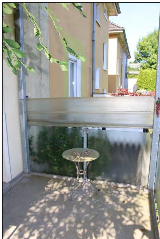
Foto Nr. 26: Erdgeschoss, WE Nr. 1, Balkon
